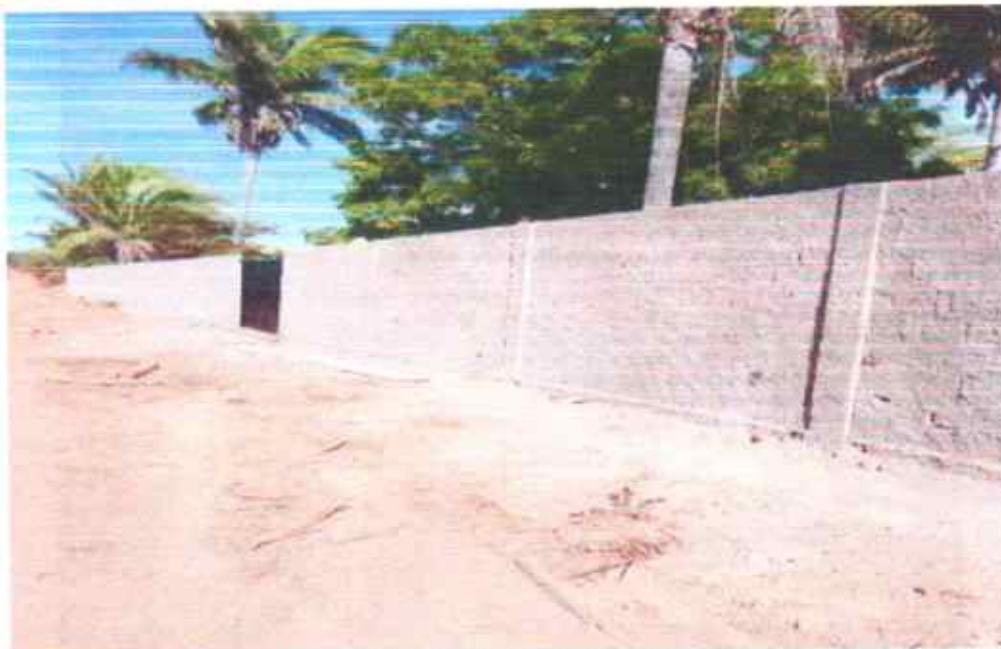
Muro e Portão (Executado)
