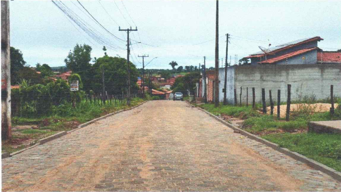
Figura 02 PAVIMENTAÇÃO EM BLOQUETES BAIRRO SÃO JOSÉ
