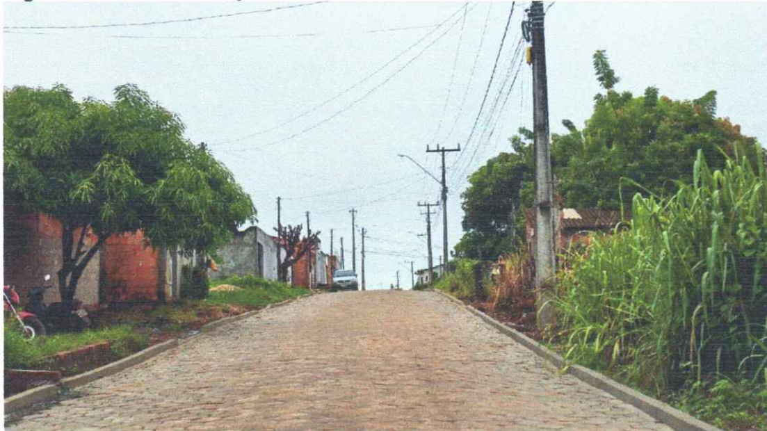
Figura 06 - PAVIMENTAÇÃO EM BLOQUETES BAIRRO SÃO JOSÉ
