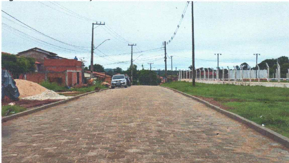
Figura 05 - PAVIMENTAÇÃO EM BLOQUETES BAIRRO SÃO JOSÉ
