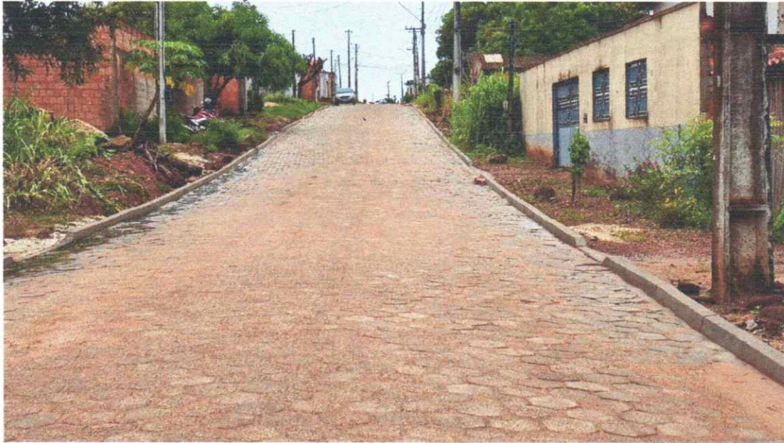
Figura 04 - PAVIMENTAÇÃO EM BLOQUETES BAIRRO SÃO JOSÉ
