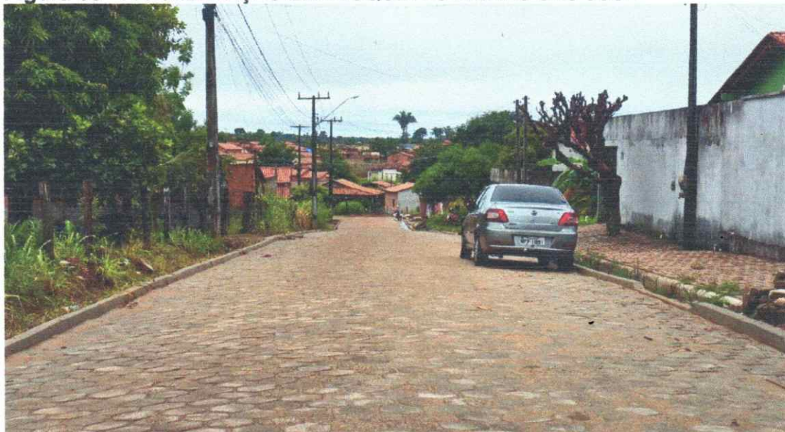
Figura 03 - PAVIMENTAÇÃO EM BLOQUETES BAIRRO SÃO JOSÉ
