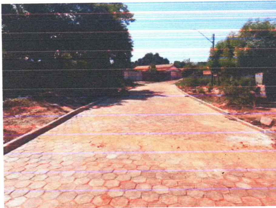
Execução de Meio Fio e Pavimentação em Bloquetes (Avenida Tocantins)
