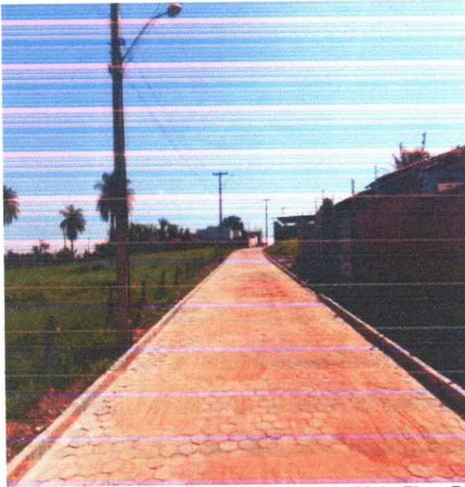
Execução de Meio Fio e Pavimentação em Bloquetes (Rua São Francisco)
