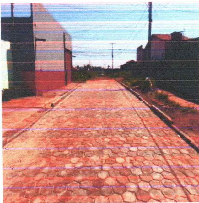
Execução de Meio Fio e Pavimentação em Bloquetes (Rua São Francisco)
