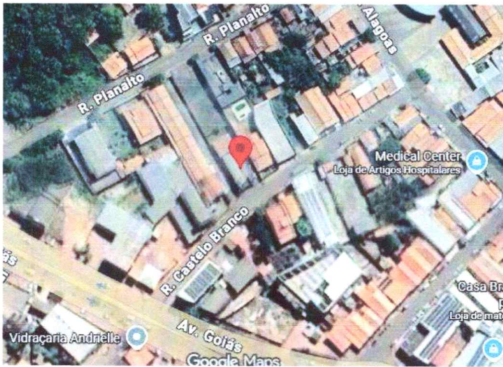
Figura 01: Localização do imóvel. Coordenadas: -5.4674737241518425, -47.88931079294183
