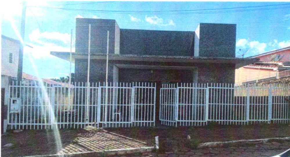
Figura 02: Fachada externa do imóvel.
