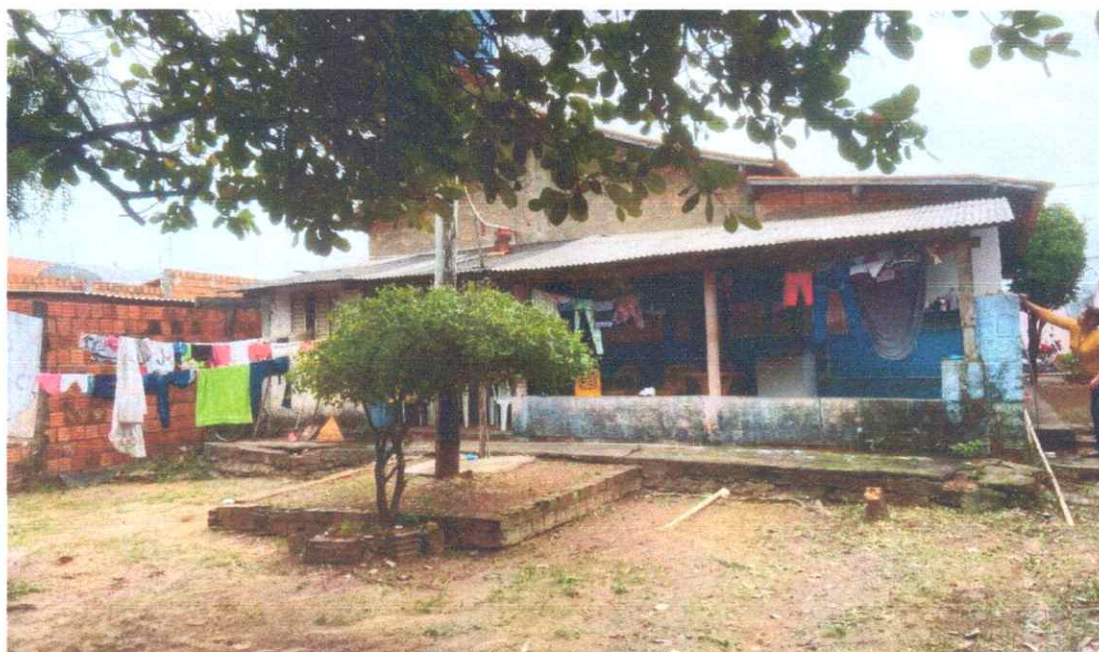
Figura 04: Fachada posterior do imóvel.
