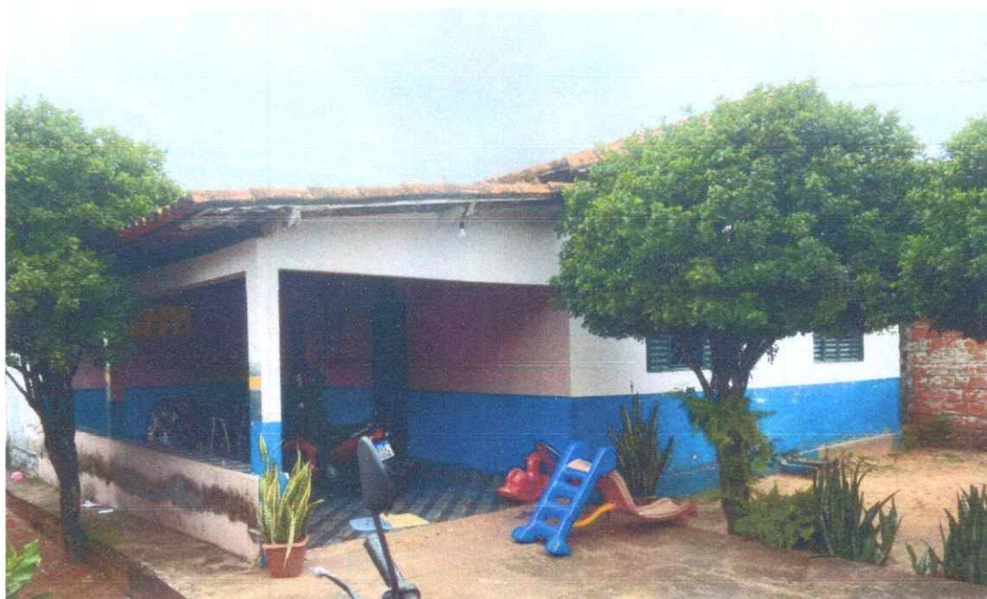
Figura 03: Fachada frontal do imóvel
