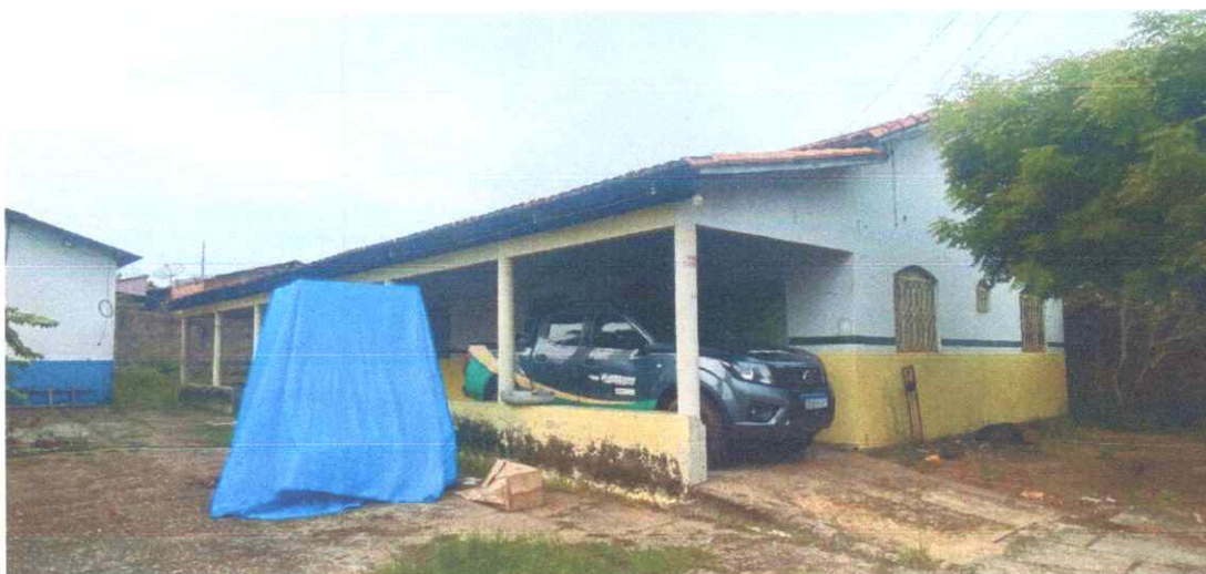
Figura 03: Fachada frontal do imóvel
