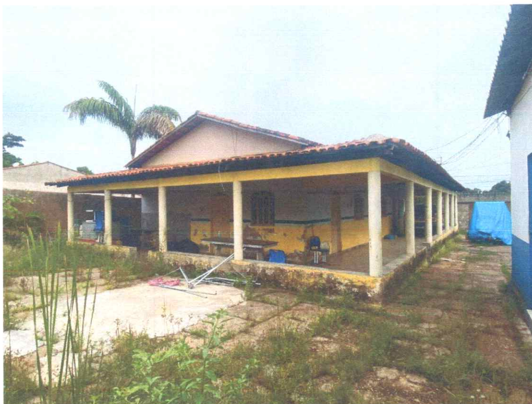
Figura 04: Fachada posterior do imóvel.
