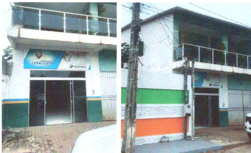
Figura 02: Fachada externa do imóvel.
