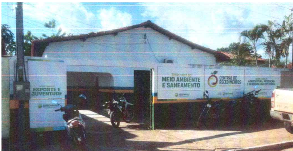
Figura 02: Fachada externa do imóvel.
