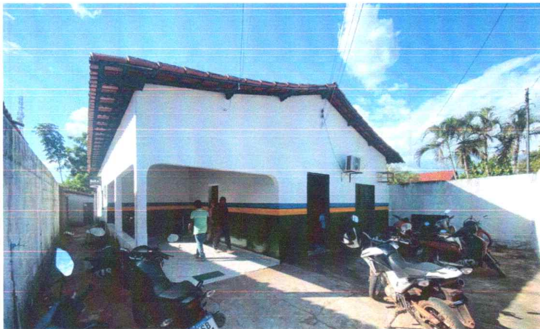
Figura 03: Fachada interna do imóvel.
