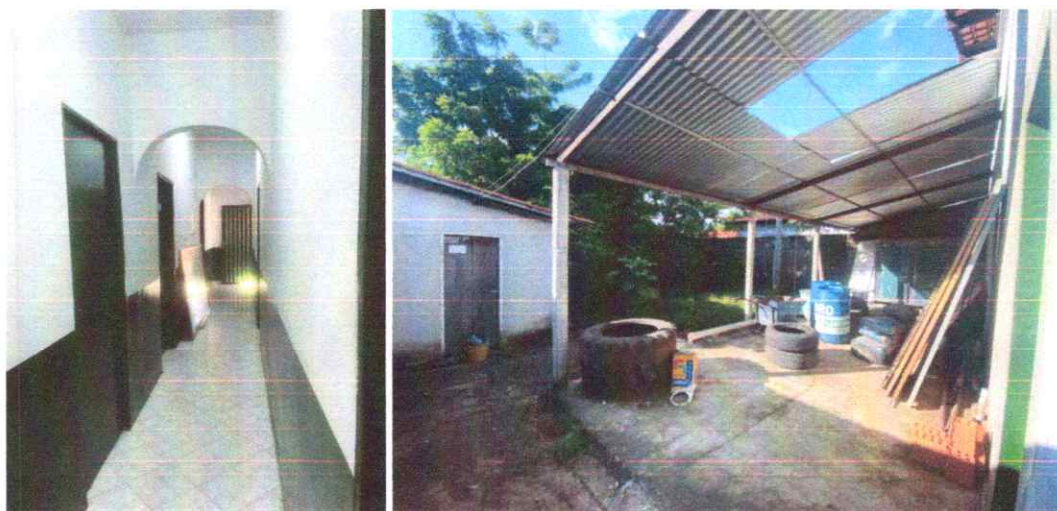
Figura 04: Dependências interna do imóvel.
