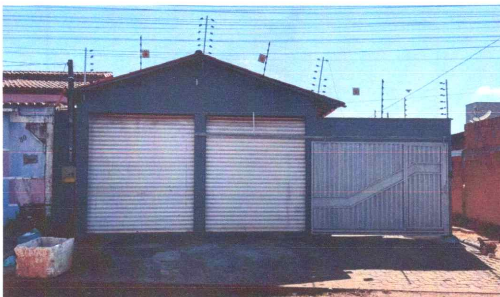
Figura 02: Fachada externa do imóvel.
