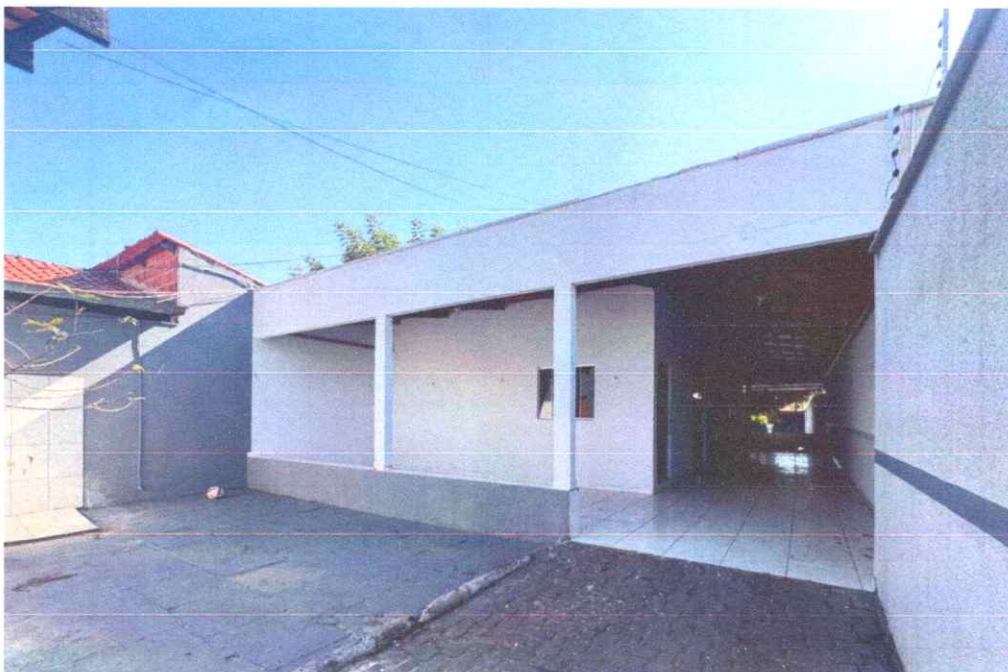
Figura 04: Fachada interna do imóvel.
