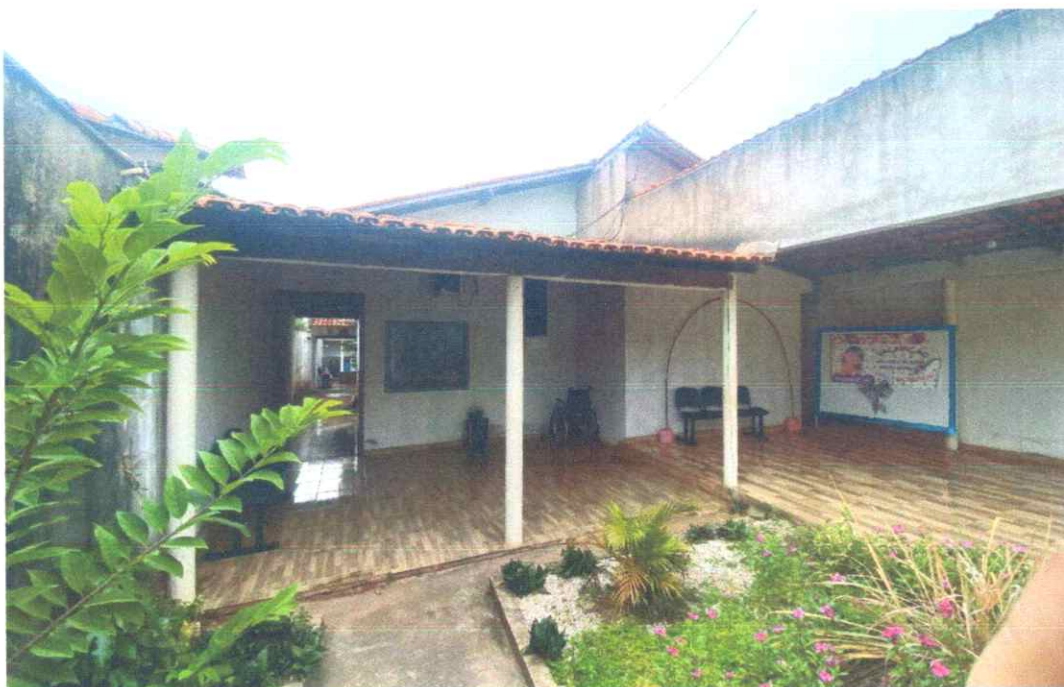
Figura 03: Fachada interna do imóvel.
