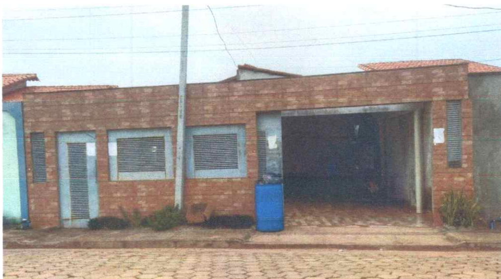
Figura 02: Fachada externa do imóvel.
