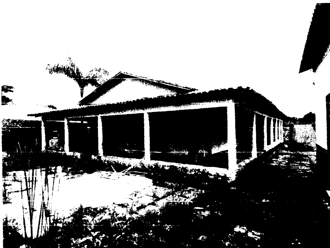
Figura 04: Fachada posterior do imóvel.
