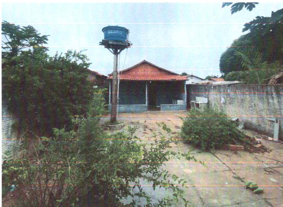
Figura 04: fachada posterior do imóvel.
