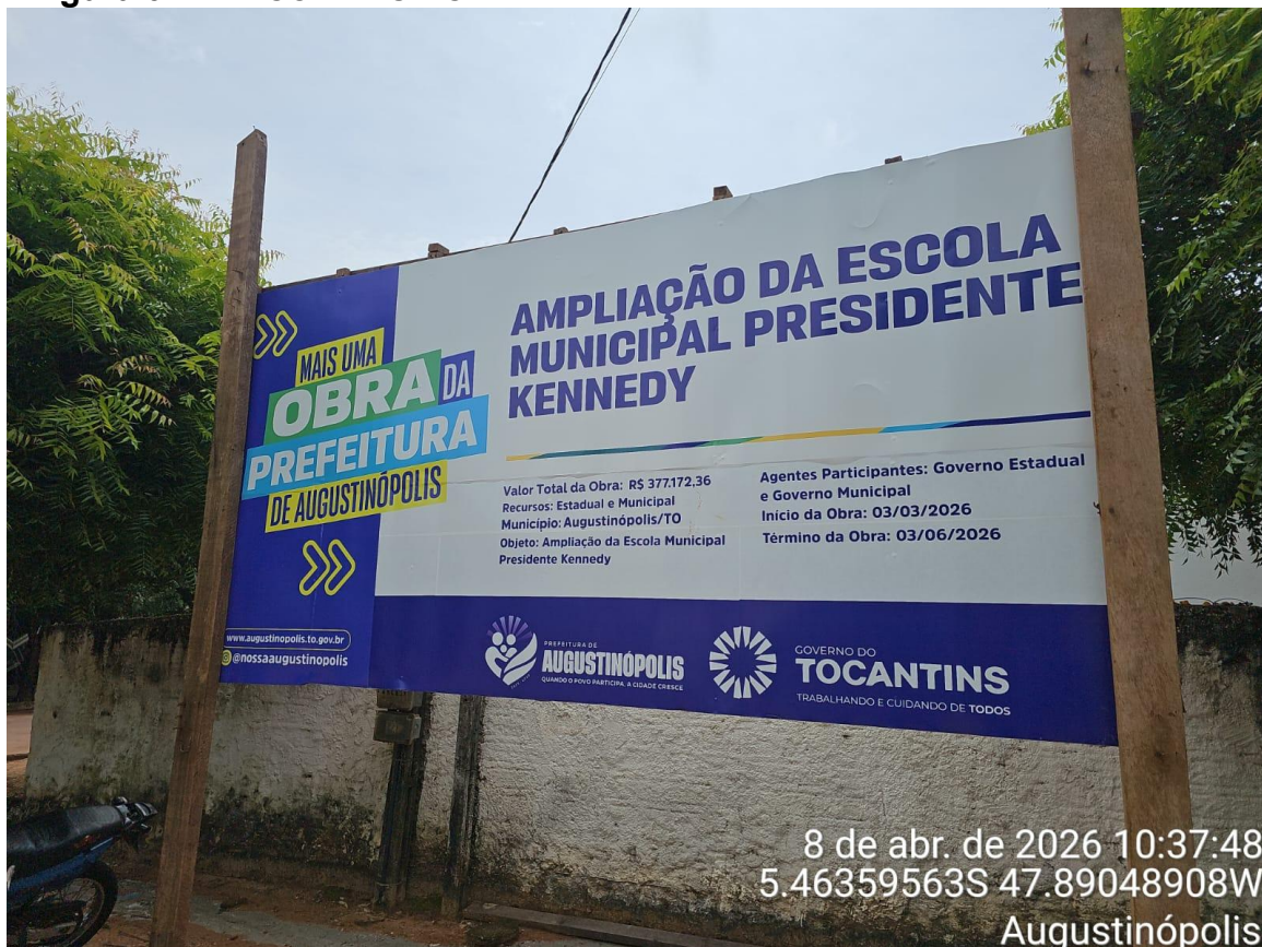
PLACA DE OBRA EM CHAPA GALVANIZADA COM ESTRUTURA EM MADEIRA
