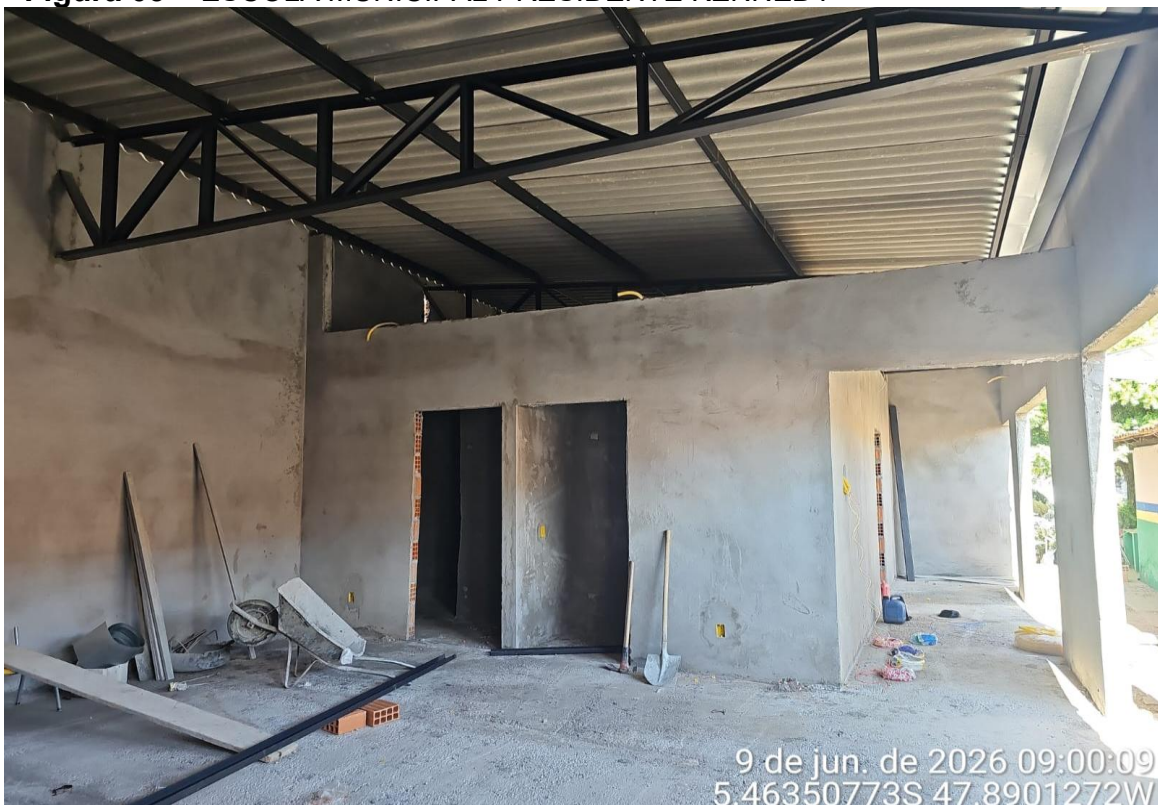
TESOURAS EM ESTRUTURA METALICA E SERVIÇOS DE REBOCO NA AREA INTENA EXECUTADOS
