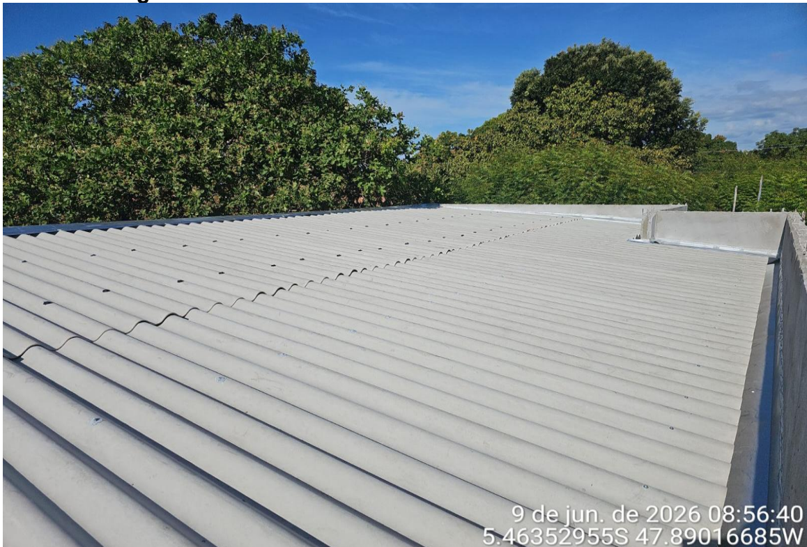
COBERTURA EM TELHA DE FIBROCIMENTO 6 MM
