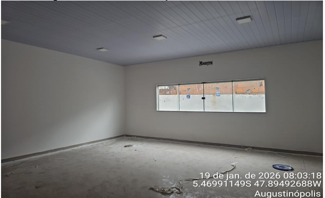
Figura 06 – REFORMA E AMPLIAÇÃO DE CRECHE MUNICIPAL
