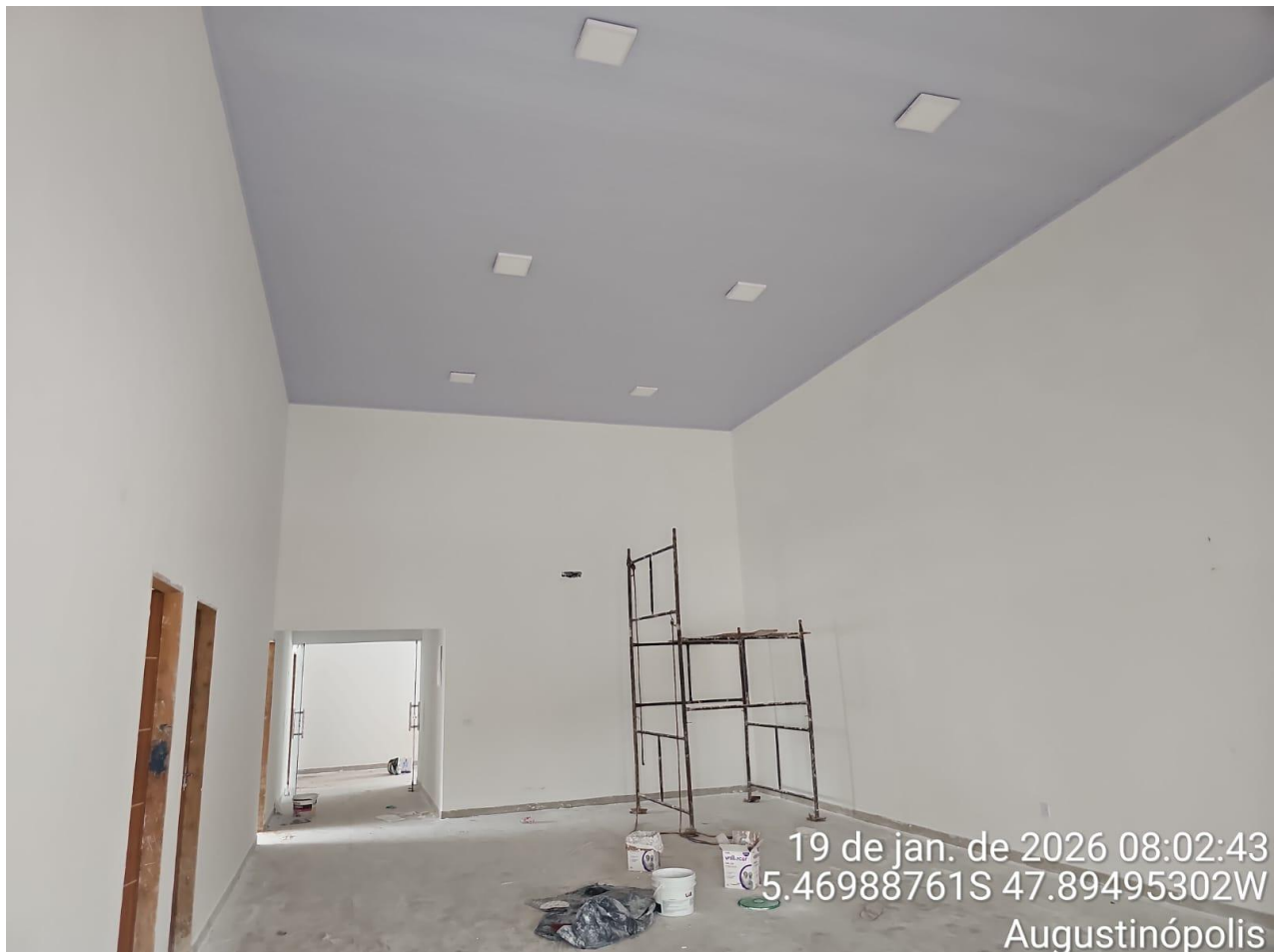
ÁREA INTERNA COM SERVIÇOS DE PINTURA E ACABAMENTOS FINALIZANDO
