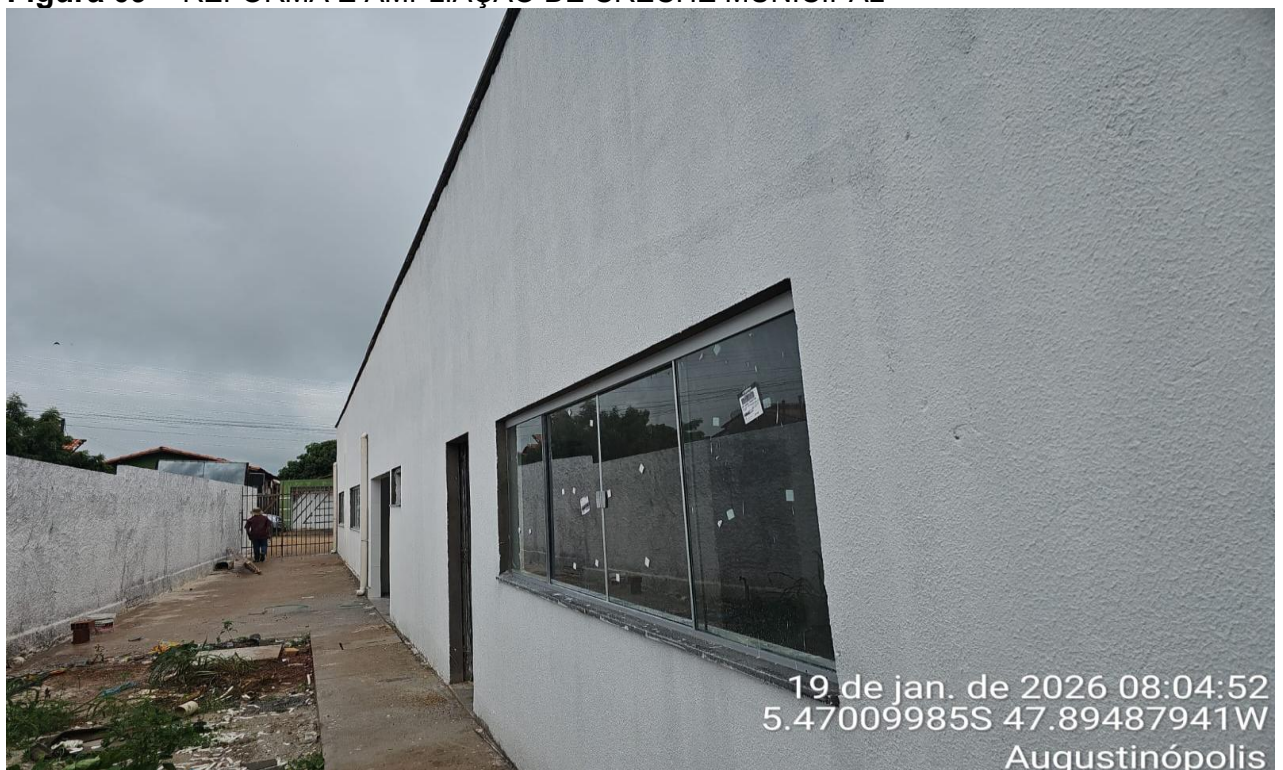
Figura 09 – REFORMA E AMPLIAÇÃO DE CRECHE MUNICIPAL
