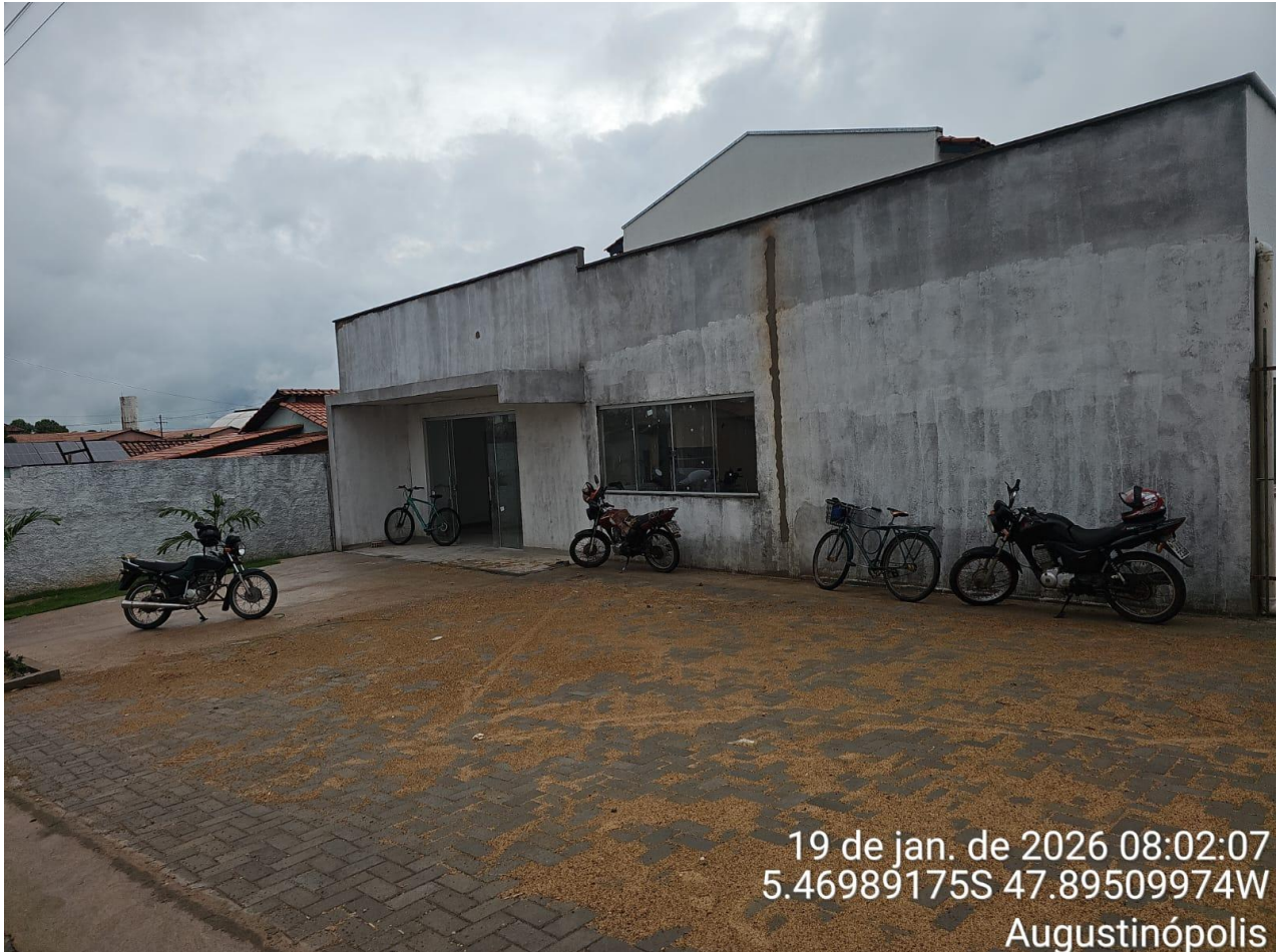
Figura 10 – REFORMA E AMPLIAÇÃO DE CRECHE MUNICIPAL
