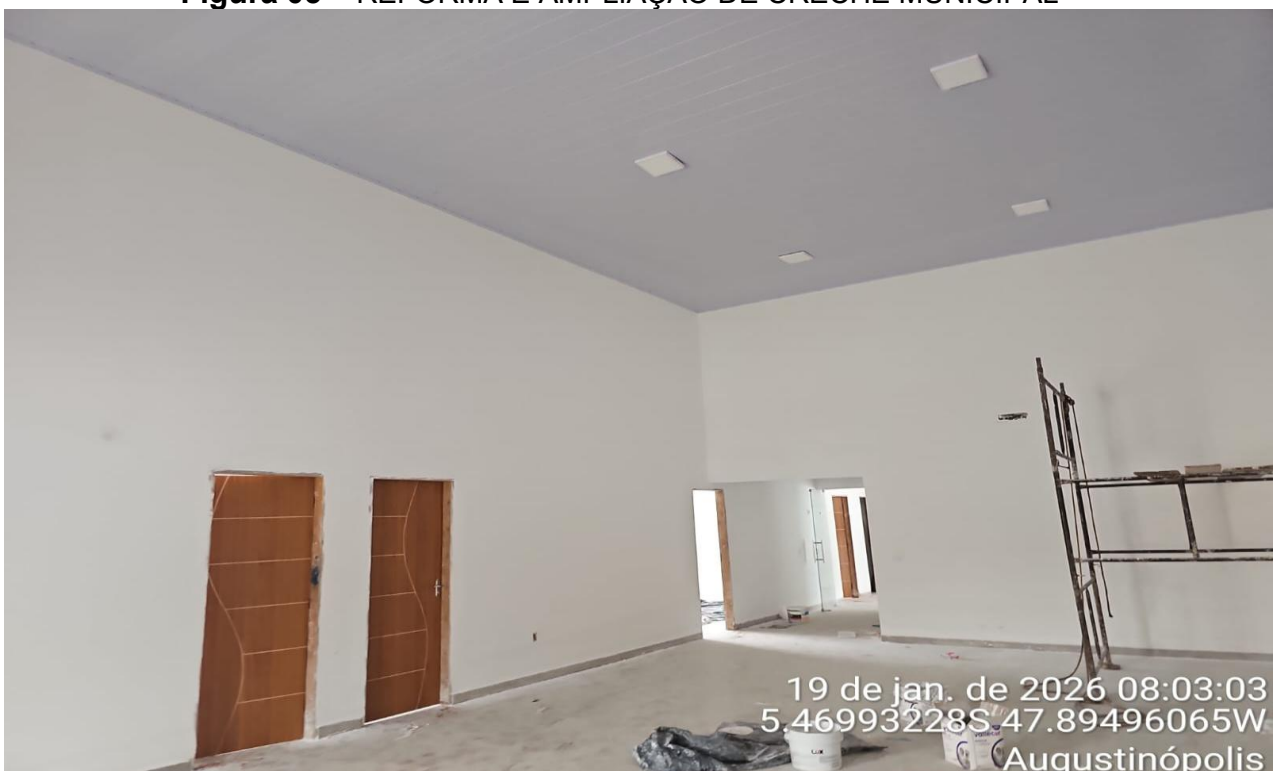
Figura 05 – REFORMA E AMPLIAÇÃO DE CRECHE MUNICIPAL
