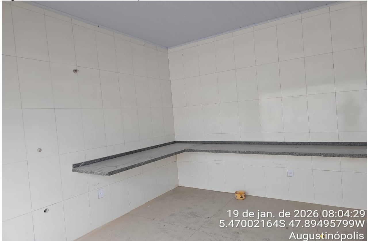
Figura 08 – REFORMA E AMPLIAÇÃO DE CRECHE MUNICIPAL
