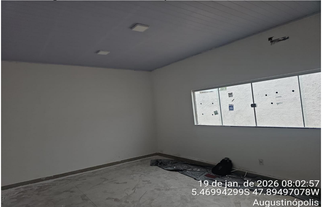
Figura 04 – REFORMA E AMPLIAÇÃO DE CRECHE MUNICIPAL
