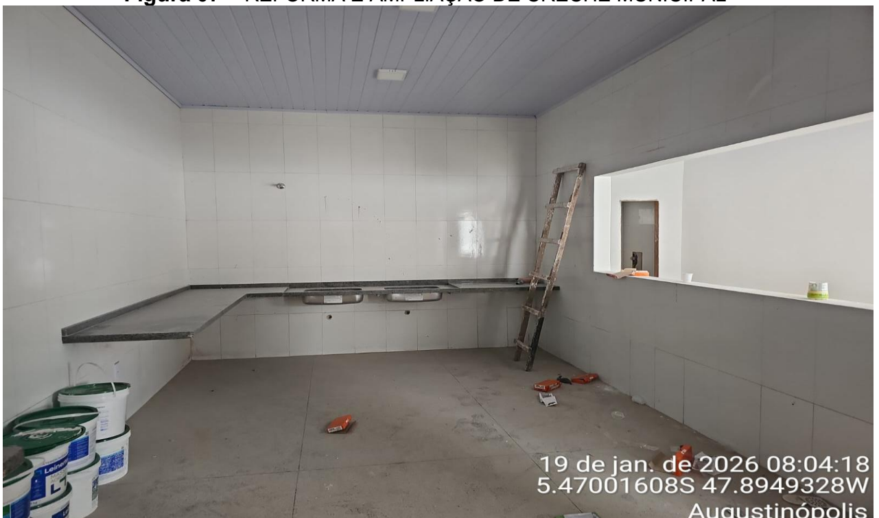
Figura 07 – REFORMA E AMPLIAÇÃO DE CRECHE MUNICIPAL
