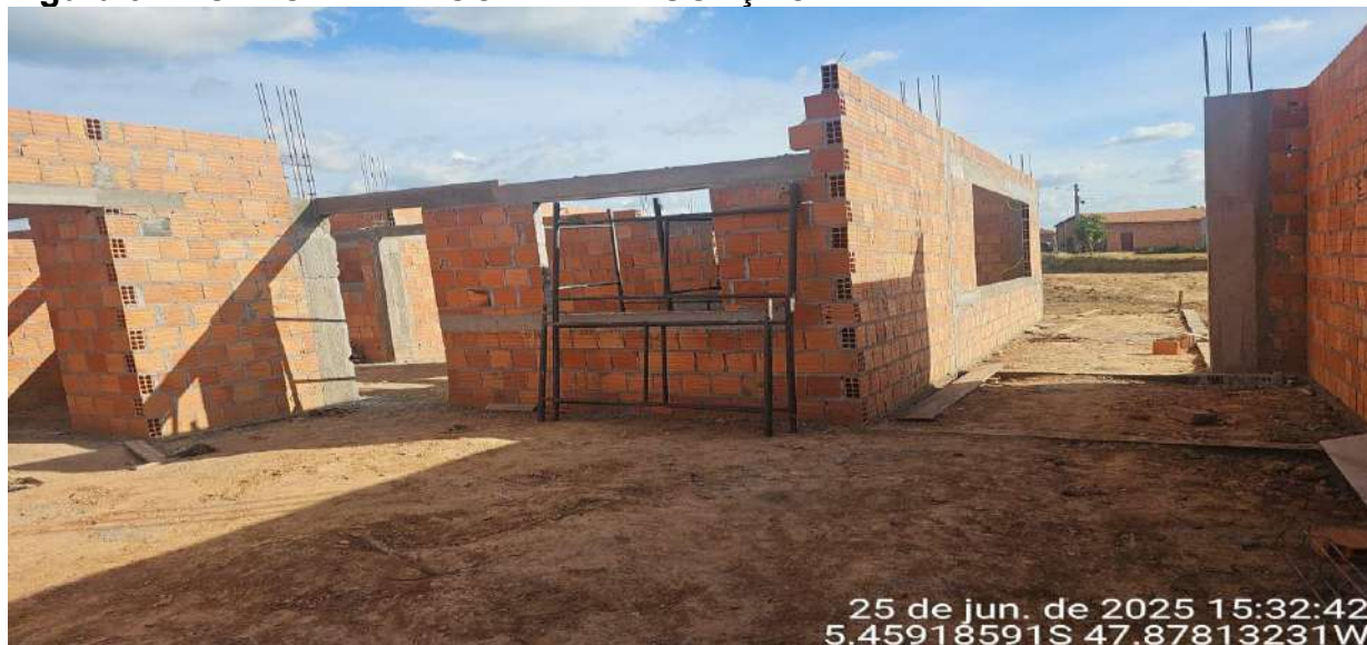
CANTEIRO DE OBRA COM SERVIÇOS DE LEVANTE DE ALVENARIA, VERGAS E CONTRA VERGAS EM ANDAMENTO
