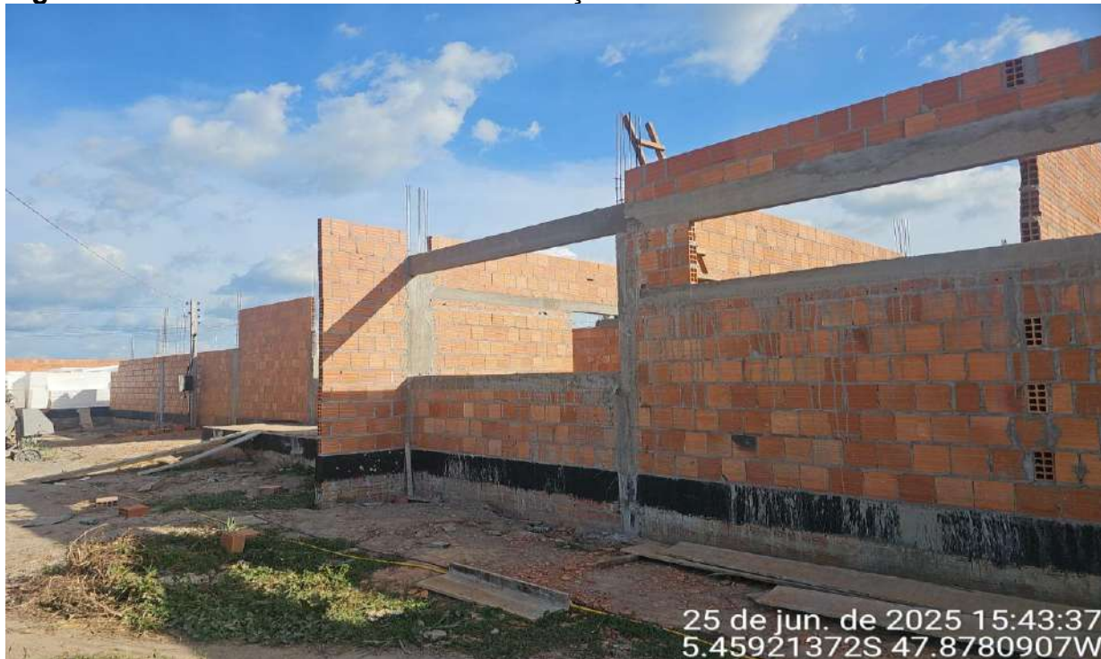
VERGAS E CONTRA VERGAS EXECUTADAS
