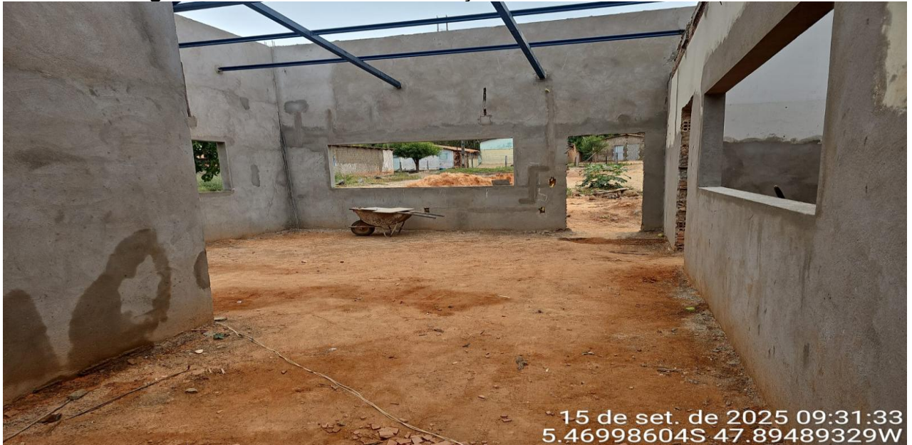
Figura 06 – REFORMA E AMPLIAÇÃO DE CRECHE MUNICIPAL
