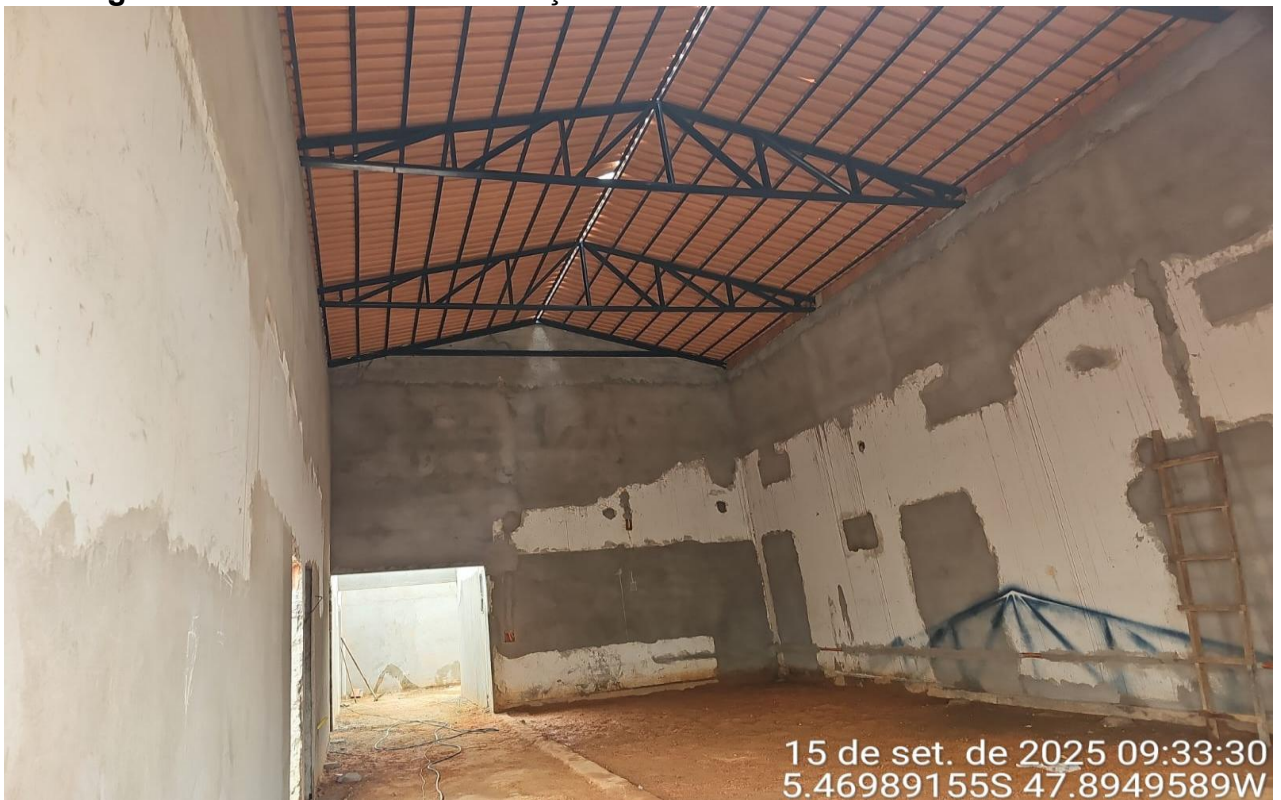
Figura 03 – REFORMA E AMPLIAÇÃO DE CRECHE MUNICIPAL
