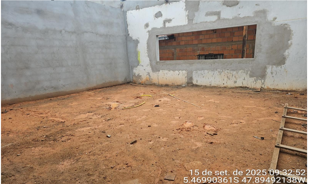
Figura 04 – REFORMA E AMPLIAÇÃO DE CRECHE MUNICIPAL
