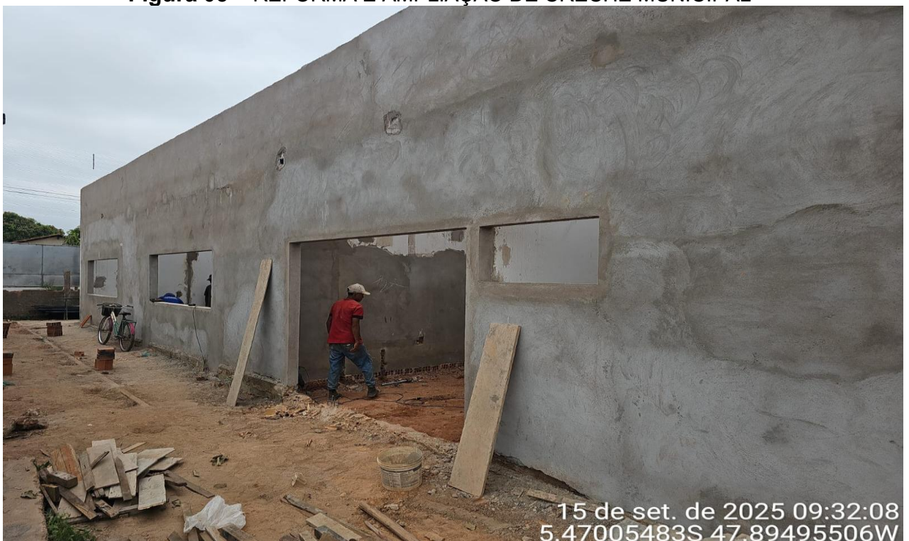
Figura 05 – REFORMA E AMPLIAÇÃO DE CRECHE MUNICIPAL
