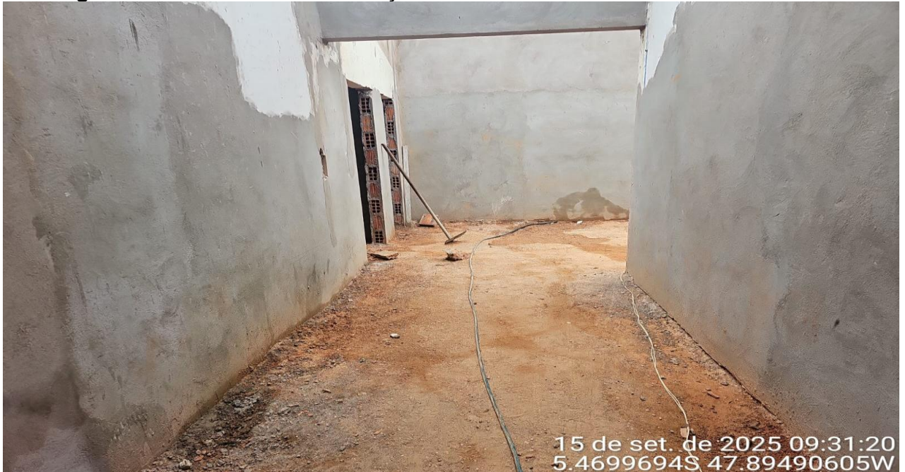
Figura 02 – REFORMA E AMPLIAÇÃO DE CRECHE MUNICIPAL
