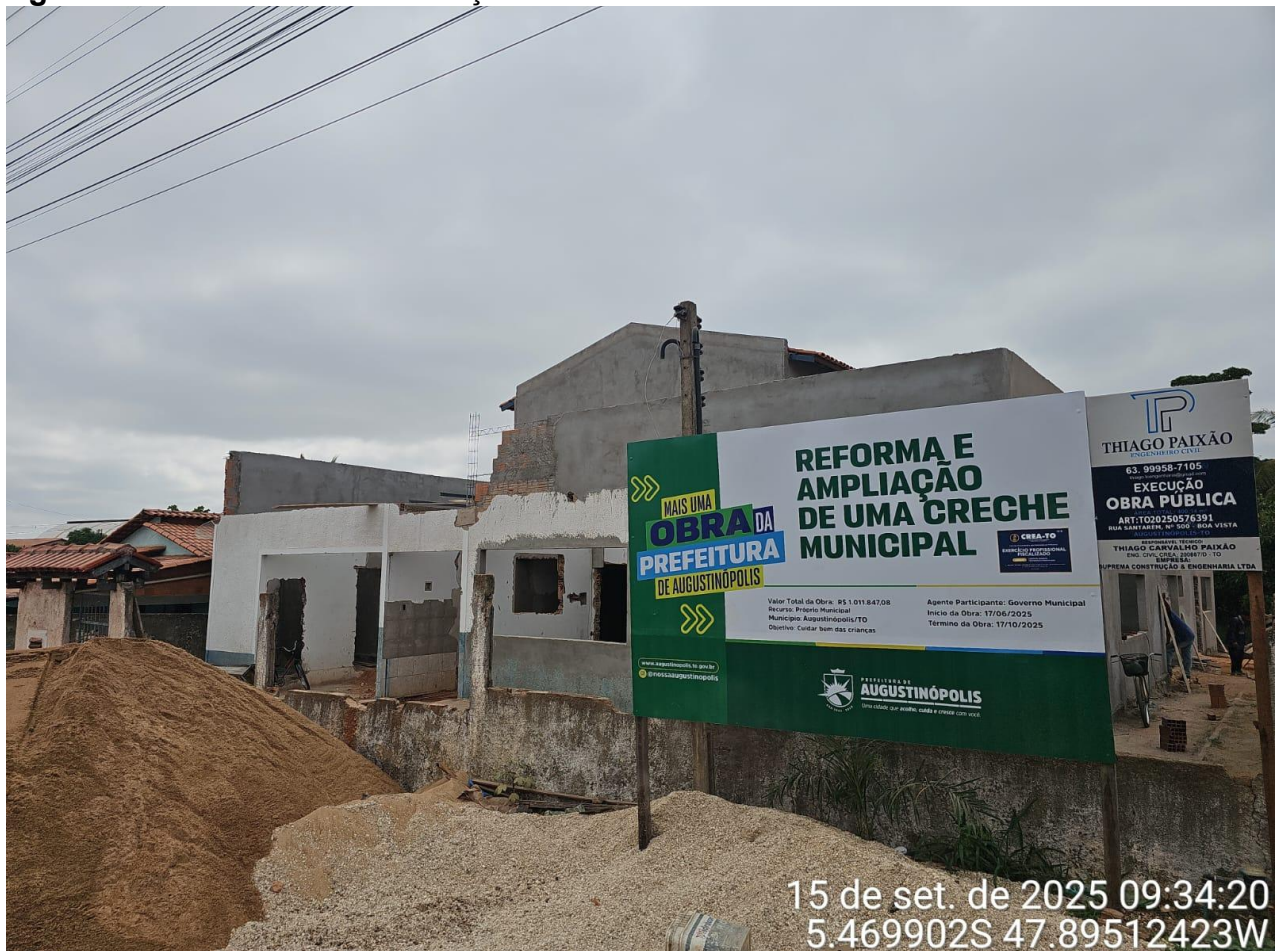
Figura 01 – REFORMA E AMPLIAÇÃO DE CRECHE MUNICIPAL
