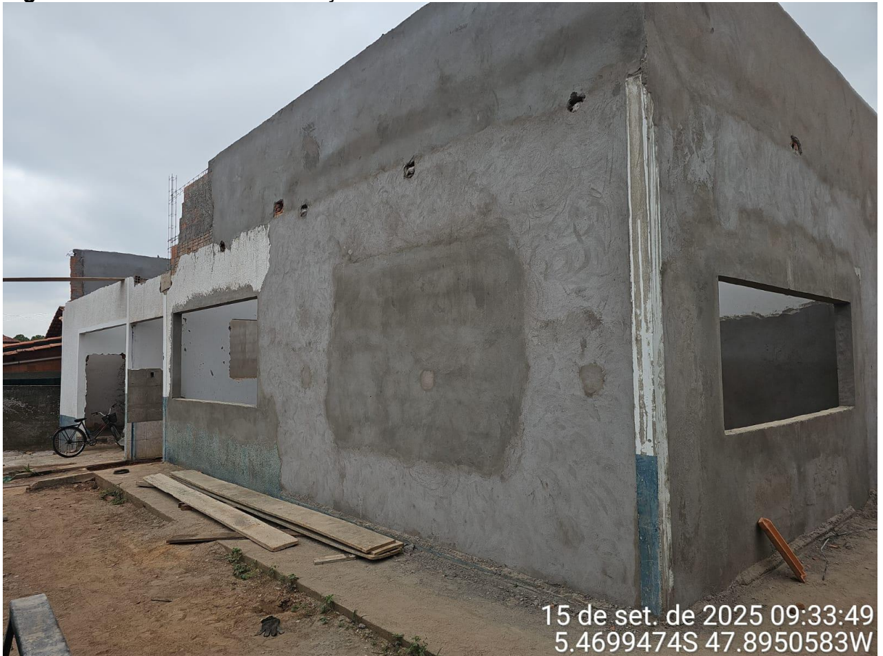
Figura 08 – REFORMA E AMPLIAÇÃO DE CRECHE MUNICIPAL
