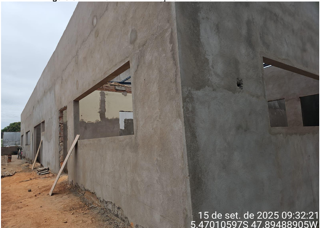
Figura 07 – REFORMA E AMPLIAÇÃO DE CRECHE MUNICIPAL
