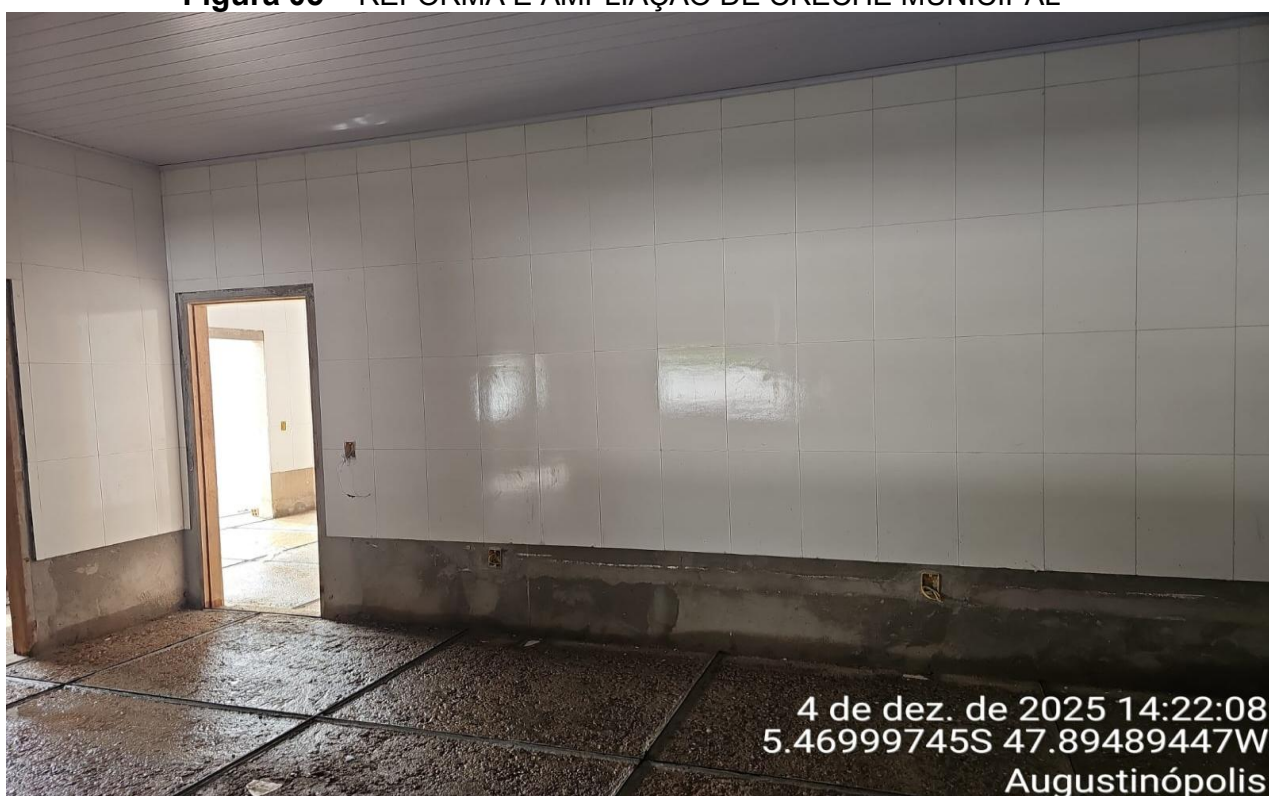
Figura 05 – REFORMA E AMPLIAÇÃO DE CRECHE MUNICIPAL
