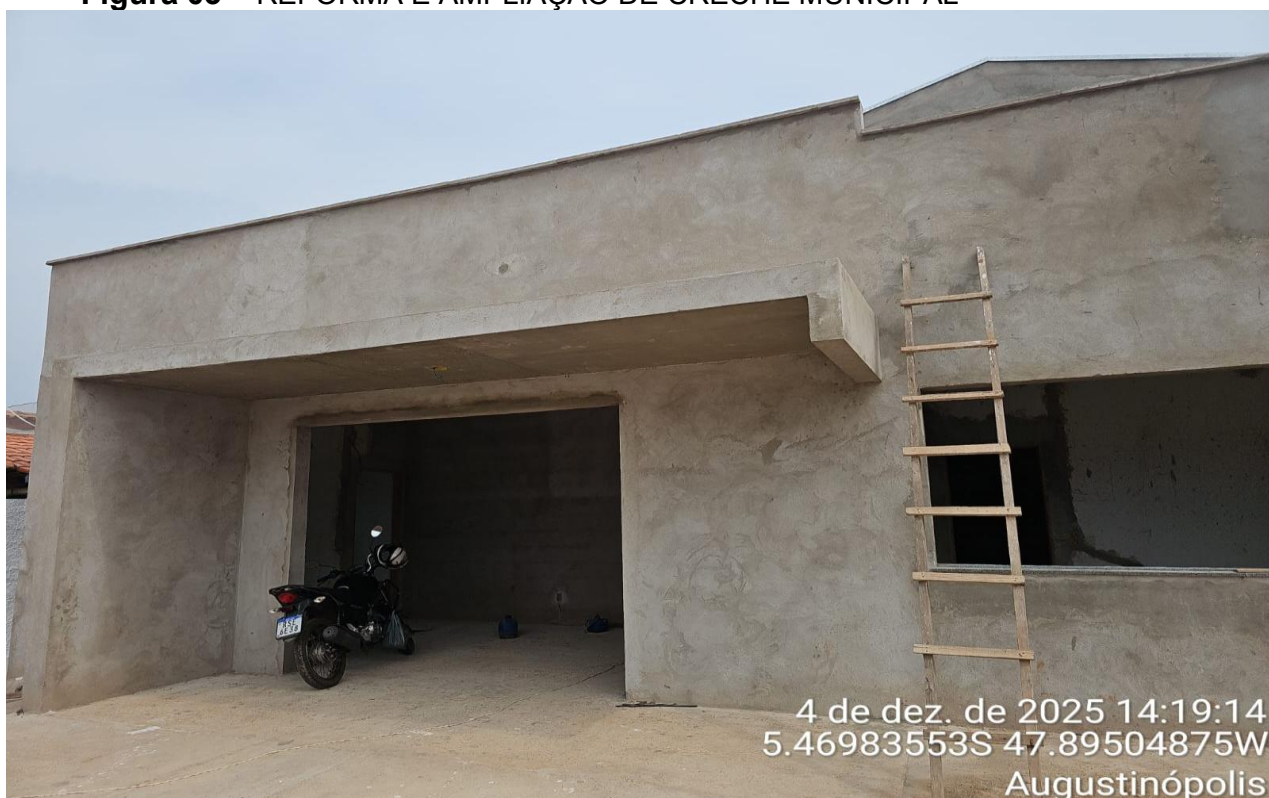
Figura 03 – REFORMA E AMPLIAÇÃO DE CRECHE MUNICIPAL
