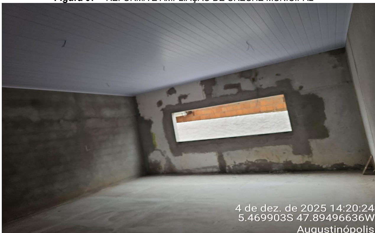
Figura 07 – REFORMA E AMPLIAÇÃO DE CRECHE MUNICIPAL
