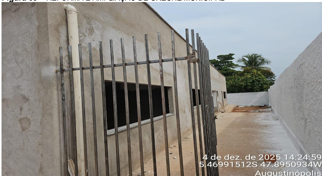
PISO E GRADE EM ÁREA EXTERNA EXECUTADOS
