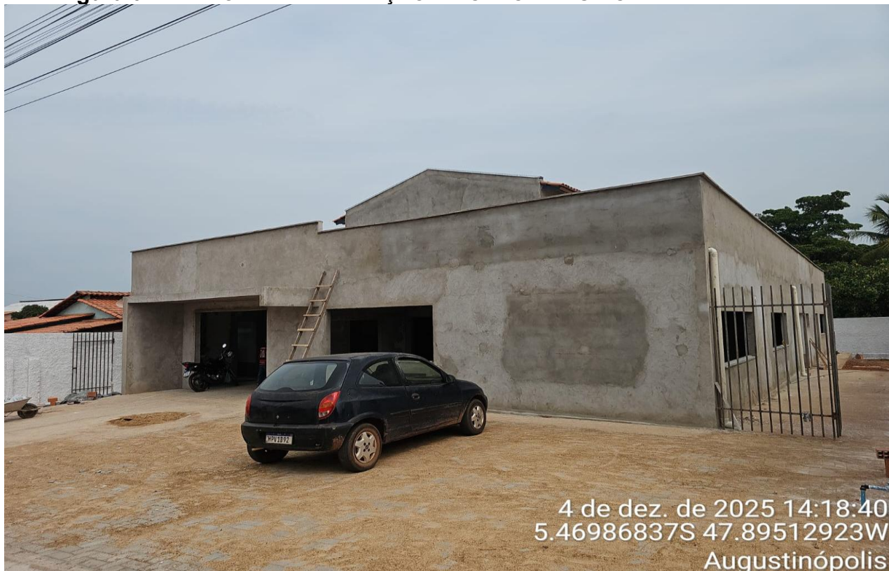
Figura 02 – REFORMA E AMPLIAÇÃO DE CRECHE MUNICIPAL
