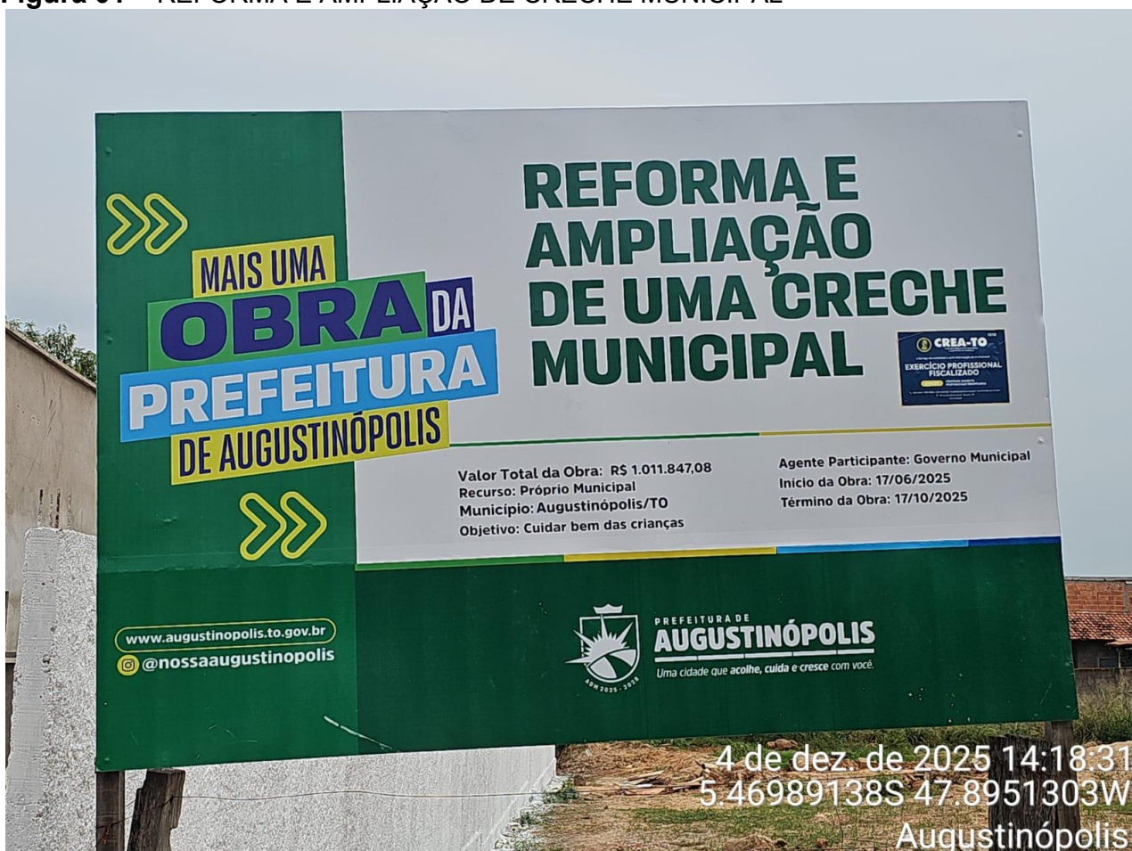
Figura 01 – REFORMA E AMPLIAÇÃO DE CRECHE MUNICIPAL
