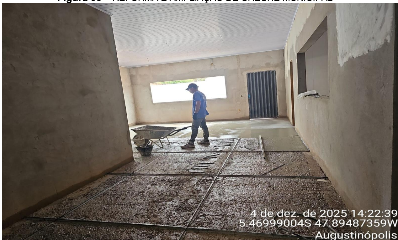
Figura 06 – REFORMA E AMPLIAÇÃO DE CRECHE MUNICIPAL
