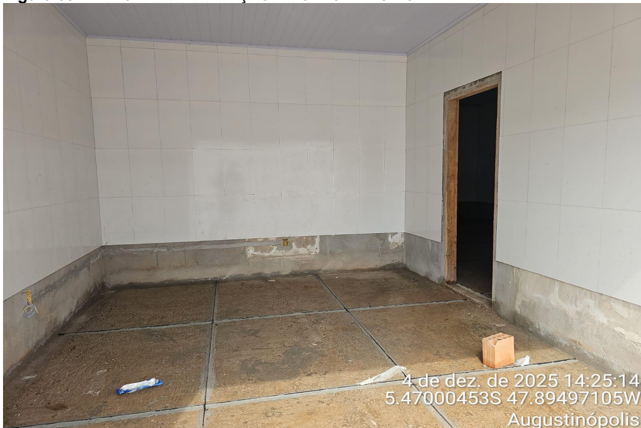
REVESTIMENTO CERAMICO EM PAREDES DA COZINHA
