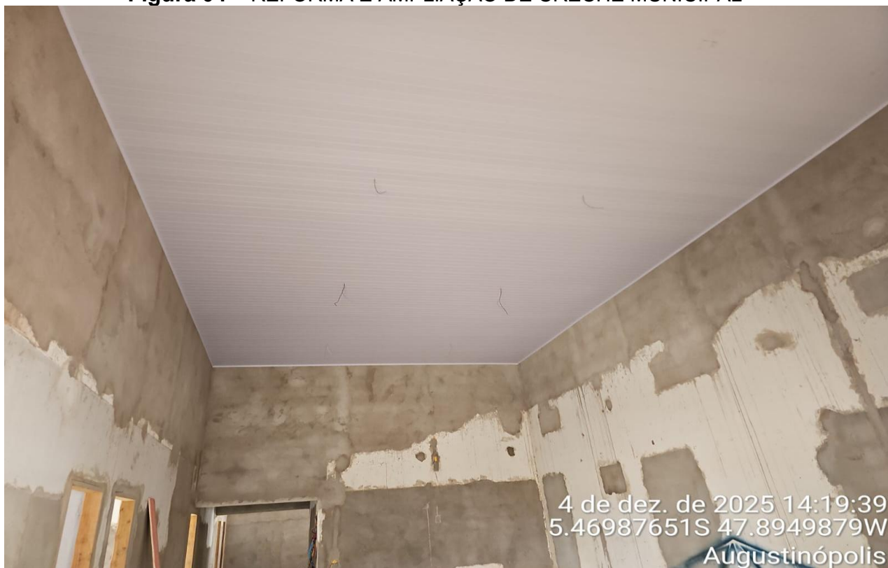
Figura 04 – REFORMA E AMPLIAÇÃO DE CRECHE MUNICIPAL
