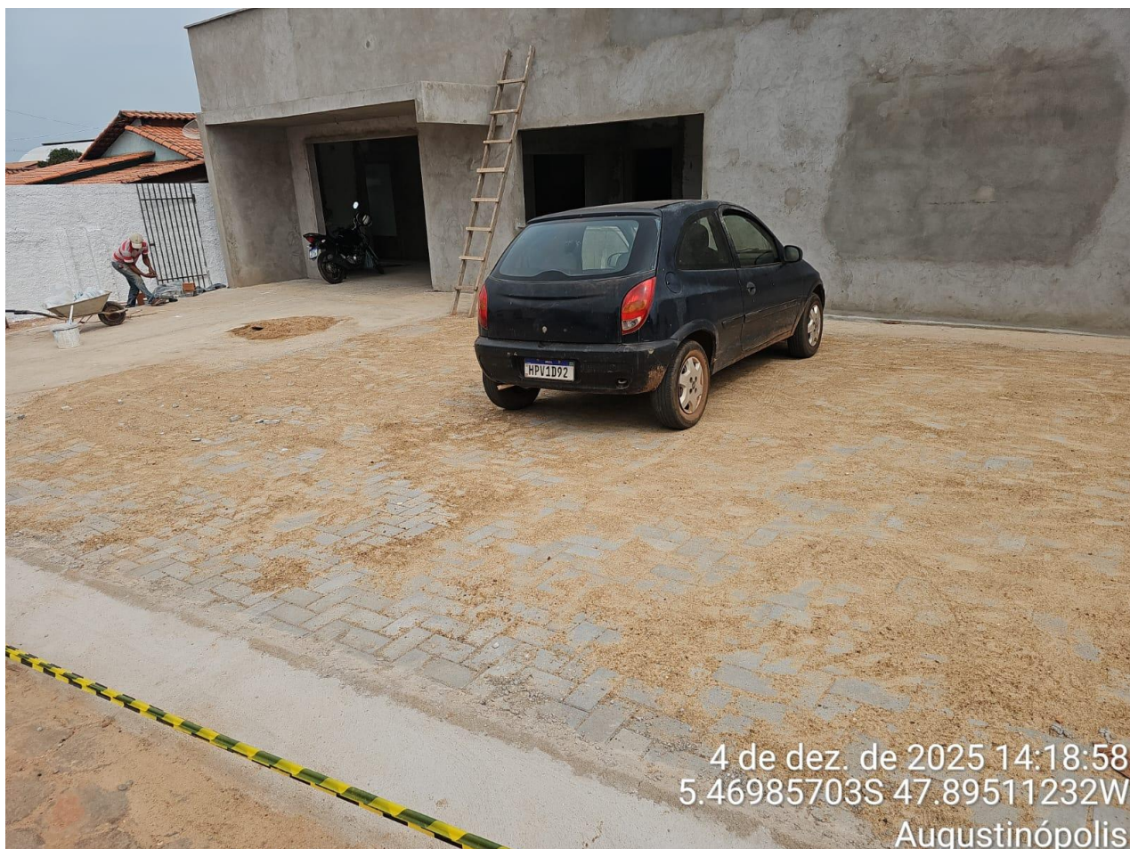
Figura 10 – REFORMA E AMPLIAÇÃO DE CRECHE MUNICIPAL
