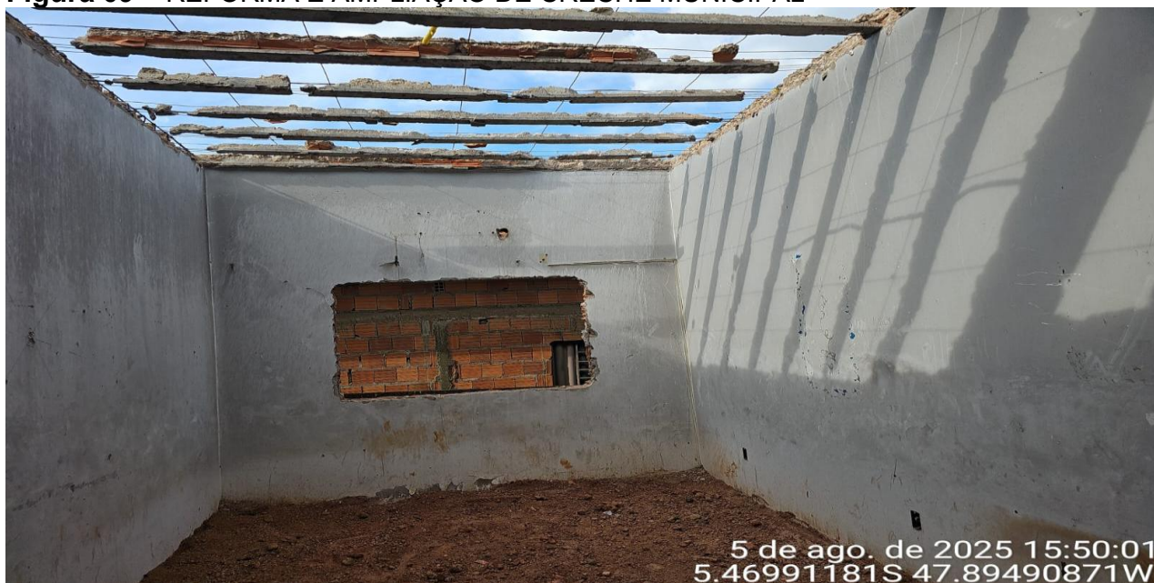
Figura 09 – REFORMA E AMPLIAÇÃO DE CRECHE MUNICIPAL
