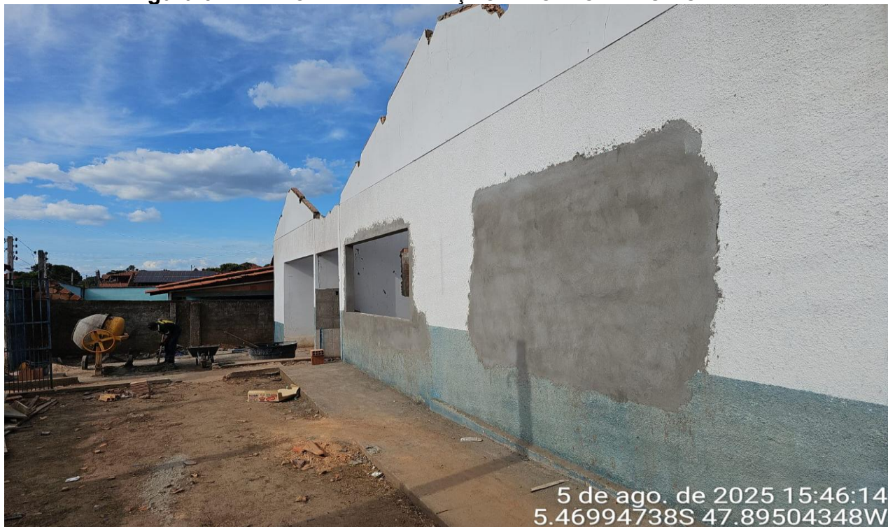
Figura 04 – REFORMA E AMPLIAÇÃO DE CRECHE MUNICIPAL
