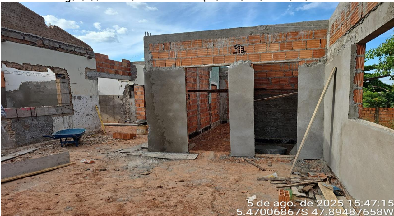
Figura 06 – REFORMA E AMPLIAÇÃO DE CRECHE MUNICIPAL
