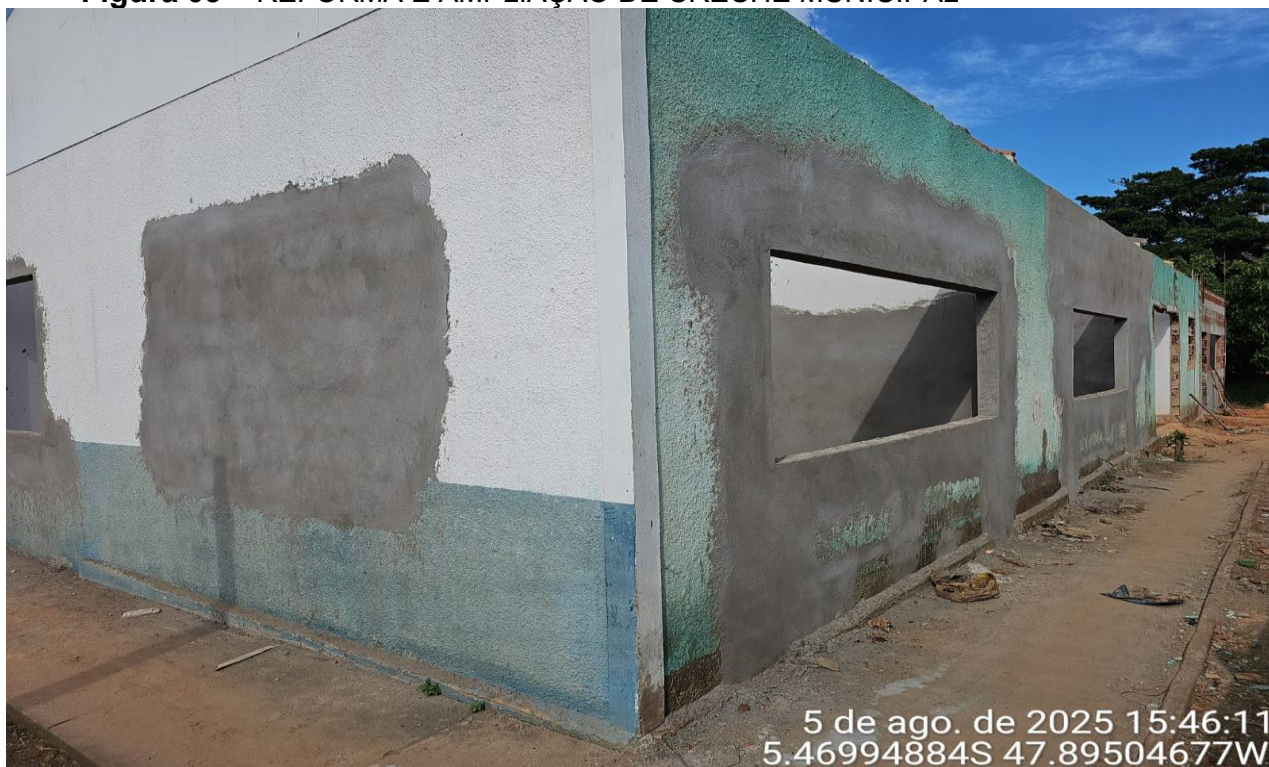
FECHAMENTOS E ABERTURA DE ESQUADRIAS EM LOCAIS DE AMPLIAÇÃO E REFORMA
