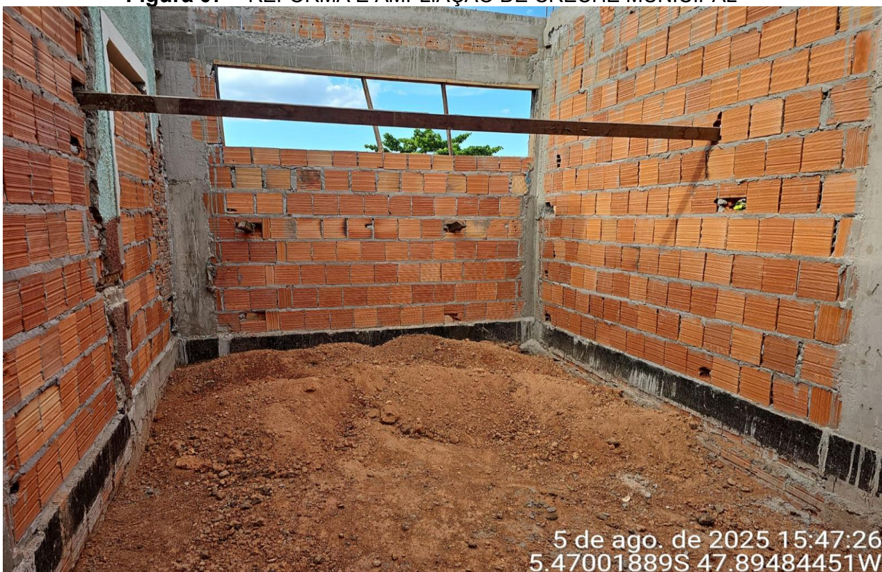
Figura 07 – REFORMA E AMPLIAÇÃO DE CRECHE MUNICIPAL
