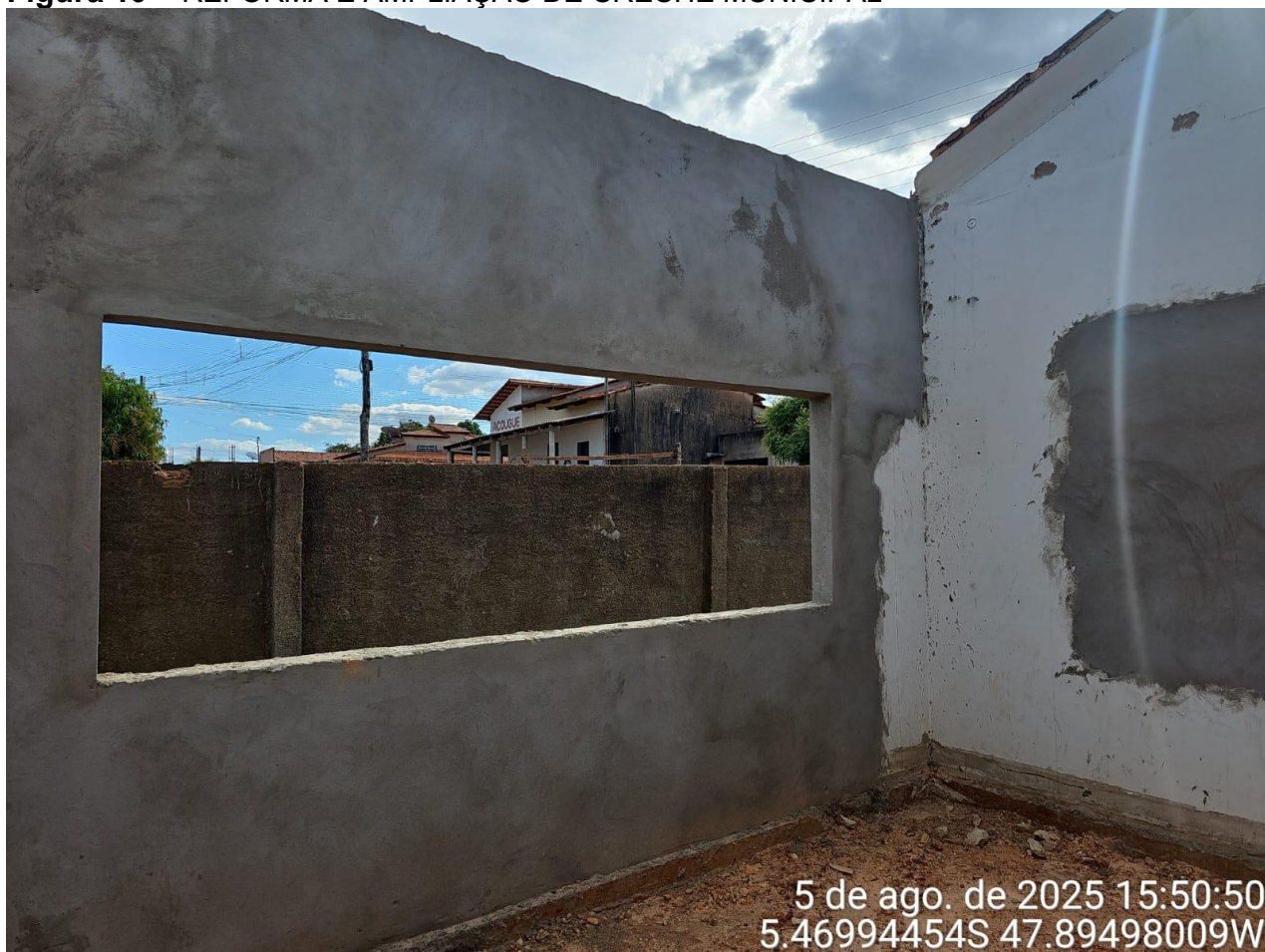
Figura 10 – REFORMA E AMPLIAÇÃO DE CRECHE MUNICIPAL
