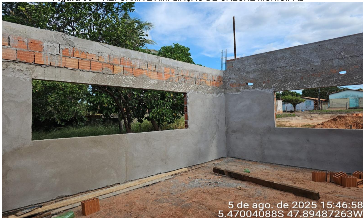
Figura 05 – REFORMA E AMPLIAÇÃO DE CRECHE MUNICIPAL
