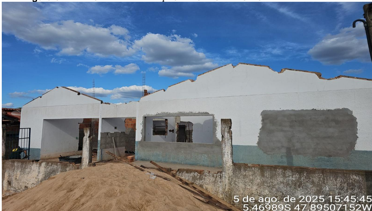
REMOÇÃO DE ESTRUTURA DE COBERTURA E TELHAS
