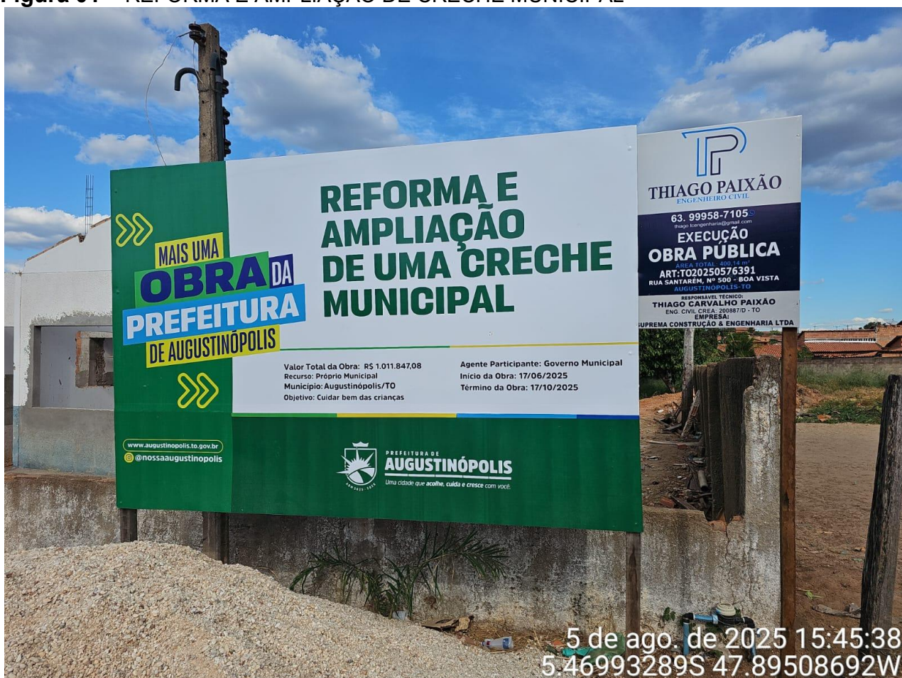
Figura 01 – REFORMA E AMPLIAÇÃO DE CRECHE MUNICIPAL
