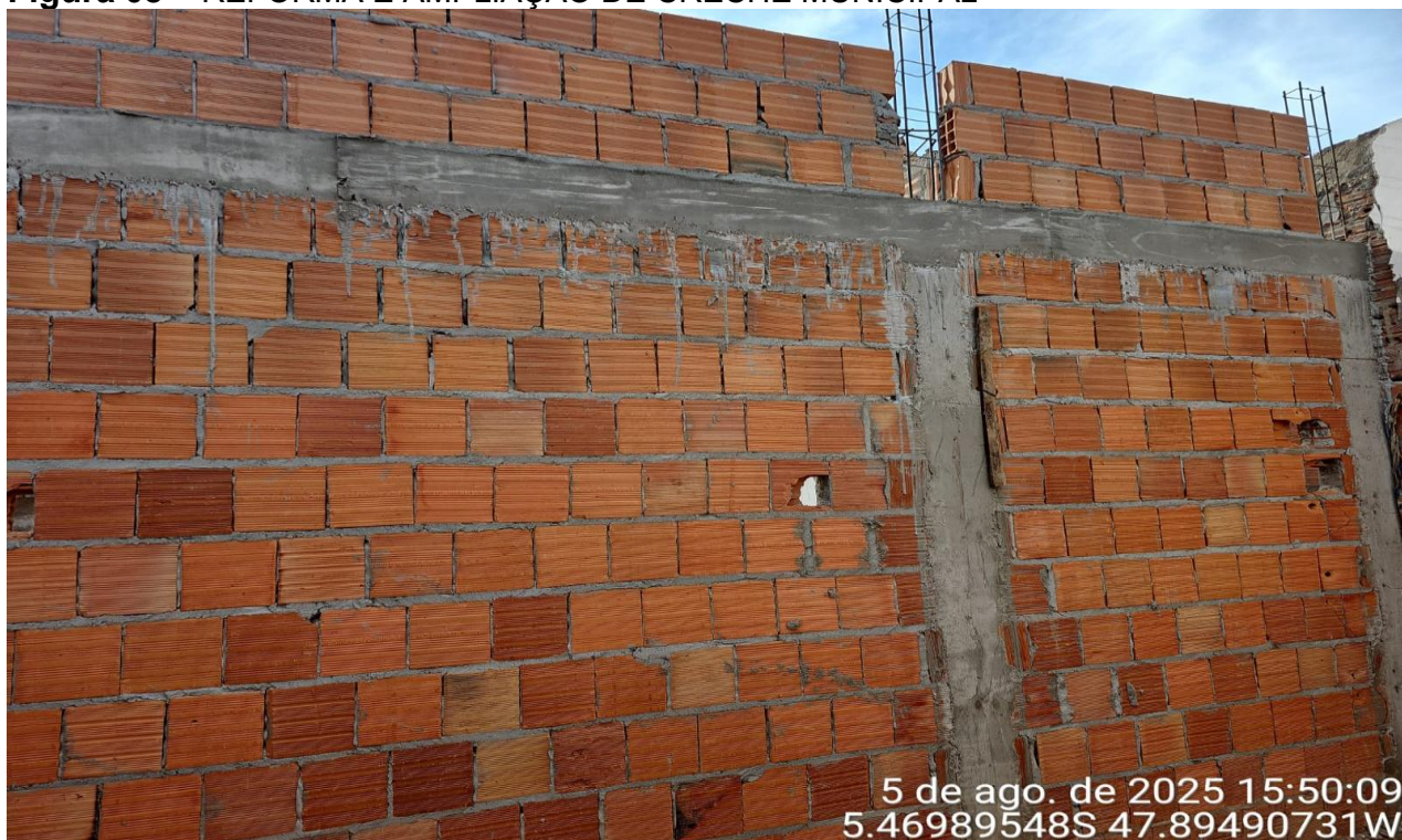
Figura 08 – REFORMA E AMPLIAÇÃO DE CRECHE MUNICIPAL
