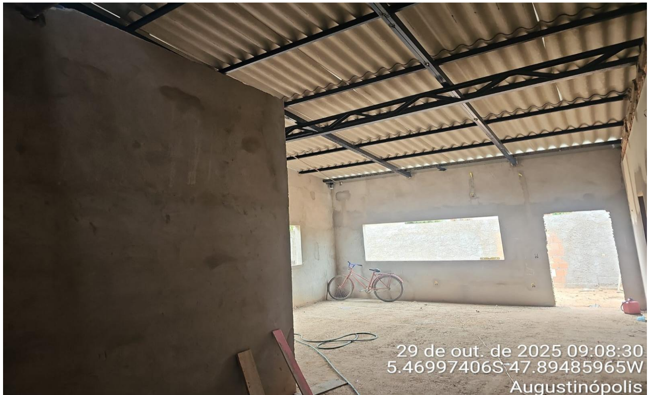
Figura 10 – REFORMA E AMPLIAÇÃO DE CRECHE MUNICIPAL
