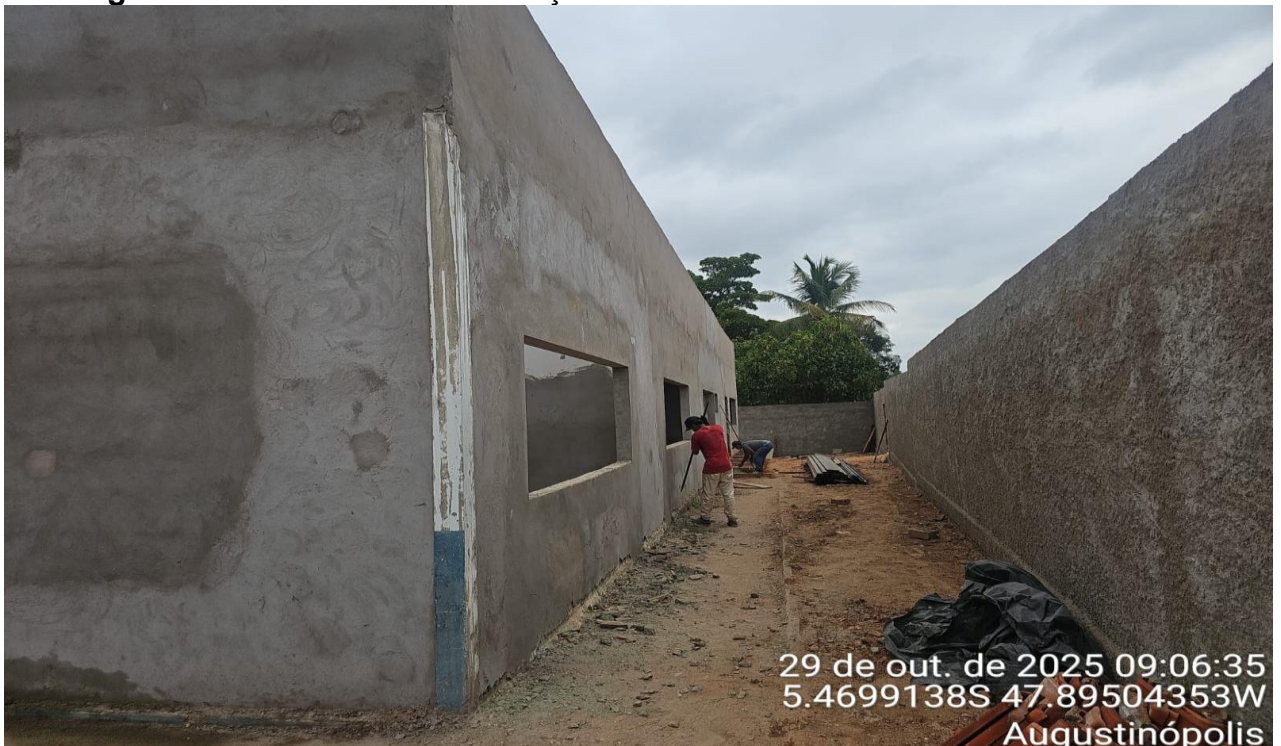
Figura 03 – REFORMA E AMPLIAÇÃO DE CRECHE MUNICIPAL
