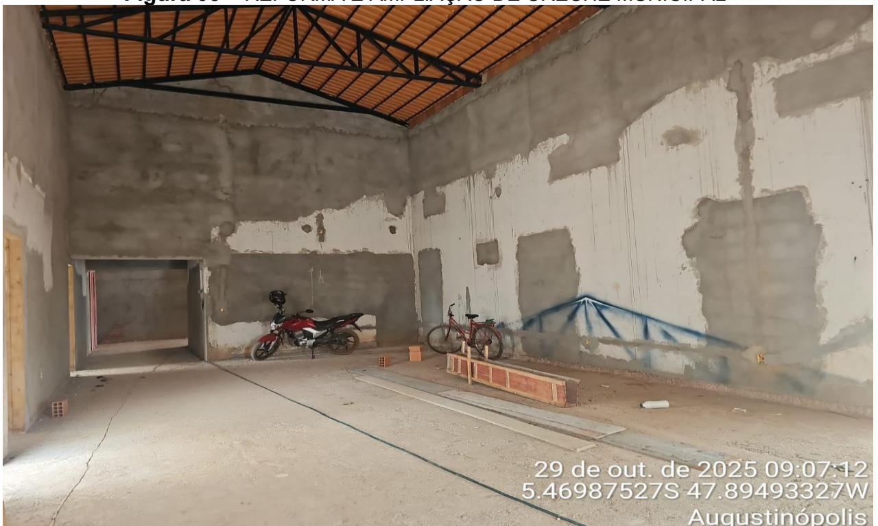
ÁREA INTERNA COM CONTRAPISO EM CONCRETO E COBERTURA EM TELHA PLAN EXECUTADOS
