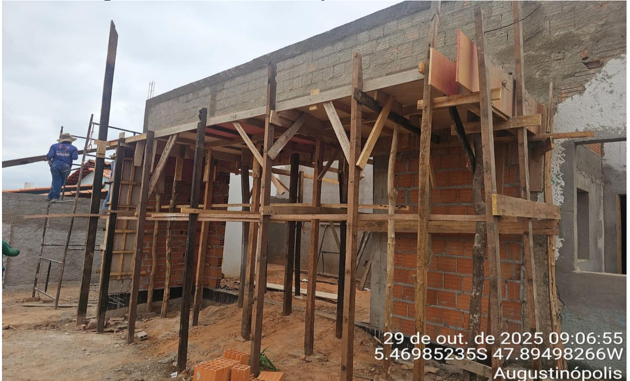
PLATIBANDA DA FACHADA COM MAQUISE EM CONCRETO ARMADO
