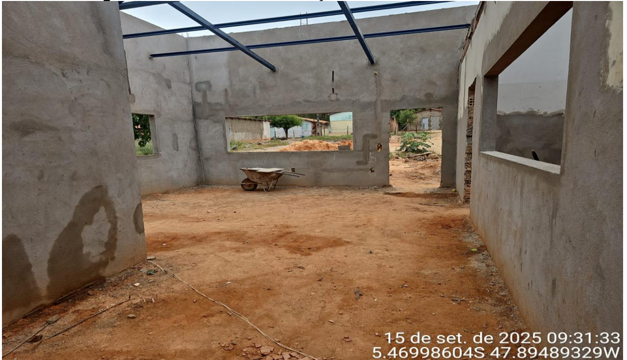
Figura 06 – REFORMA E AMPLIAÇÃO DE CRECHE MUNICIPAL
