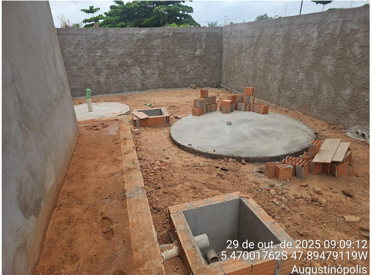
FOSSA E SUMIDOURO EXECUTADO COM CAIXAS DE PASSAGEM
