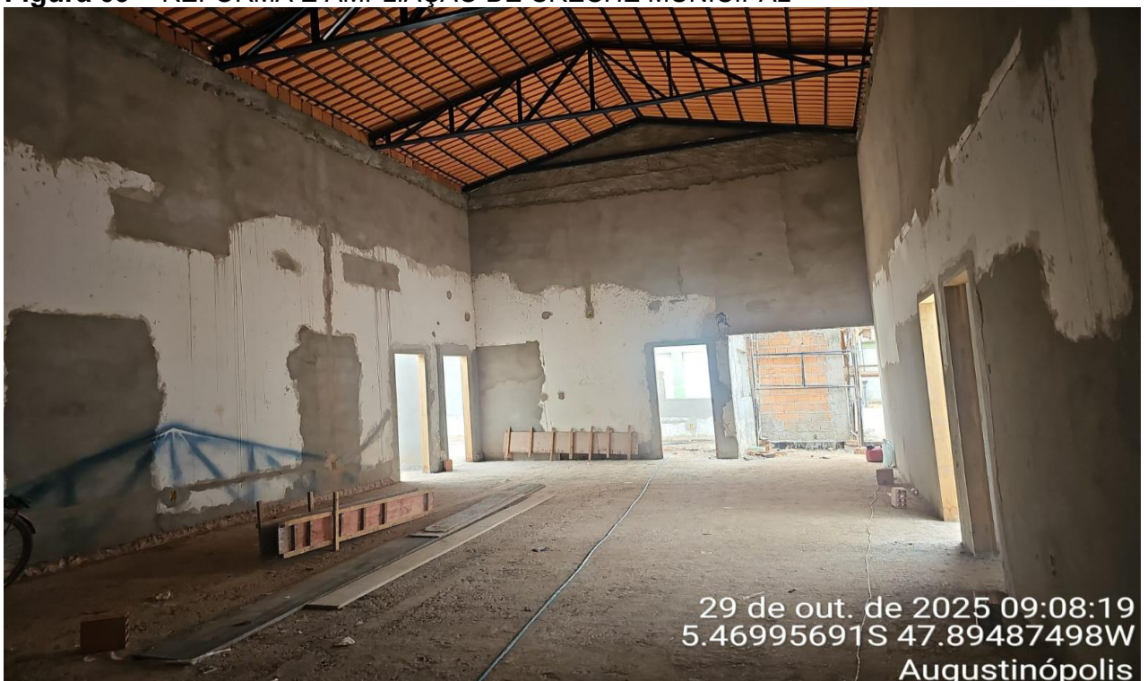
Figura 09 – REFORMA E AMPLIAÇÃO DE CRECHE MUNICIPAL
