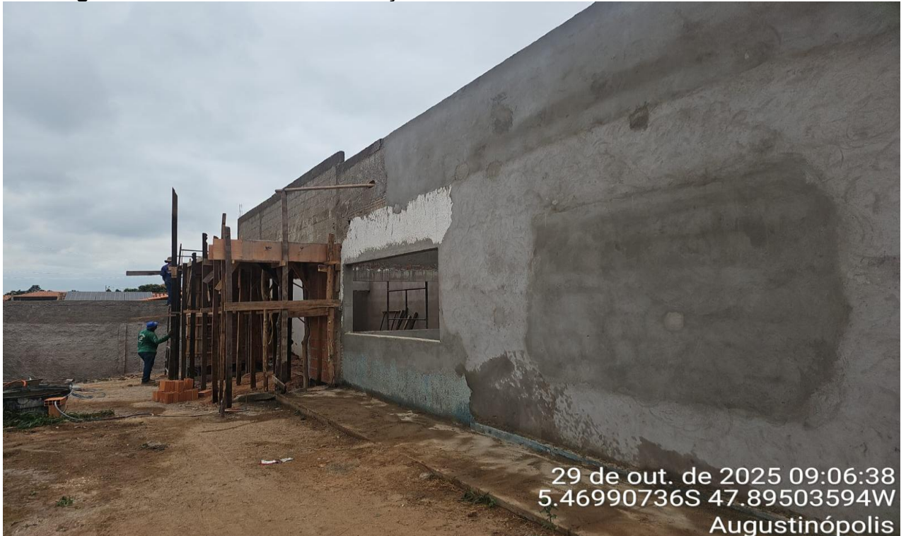
Figura 02 – REFORMA E AMPLIAÇÃO DE CRECHE MUNICIPAL
