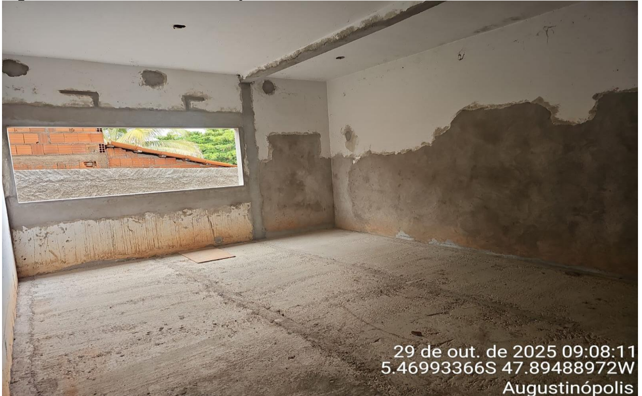
Figura 08 – REFORMA E AMPLIAÇÃO DE CRECHE MUNICIPAL
