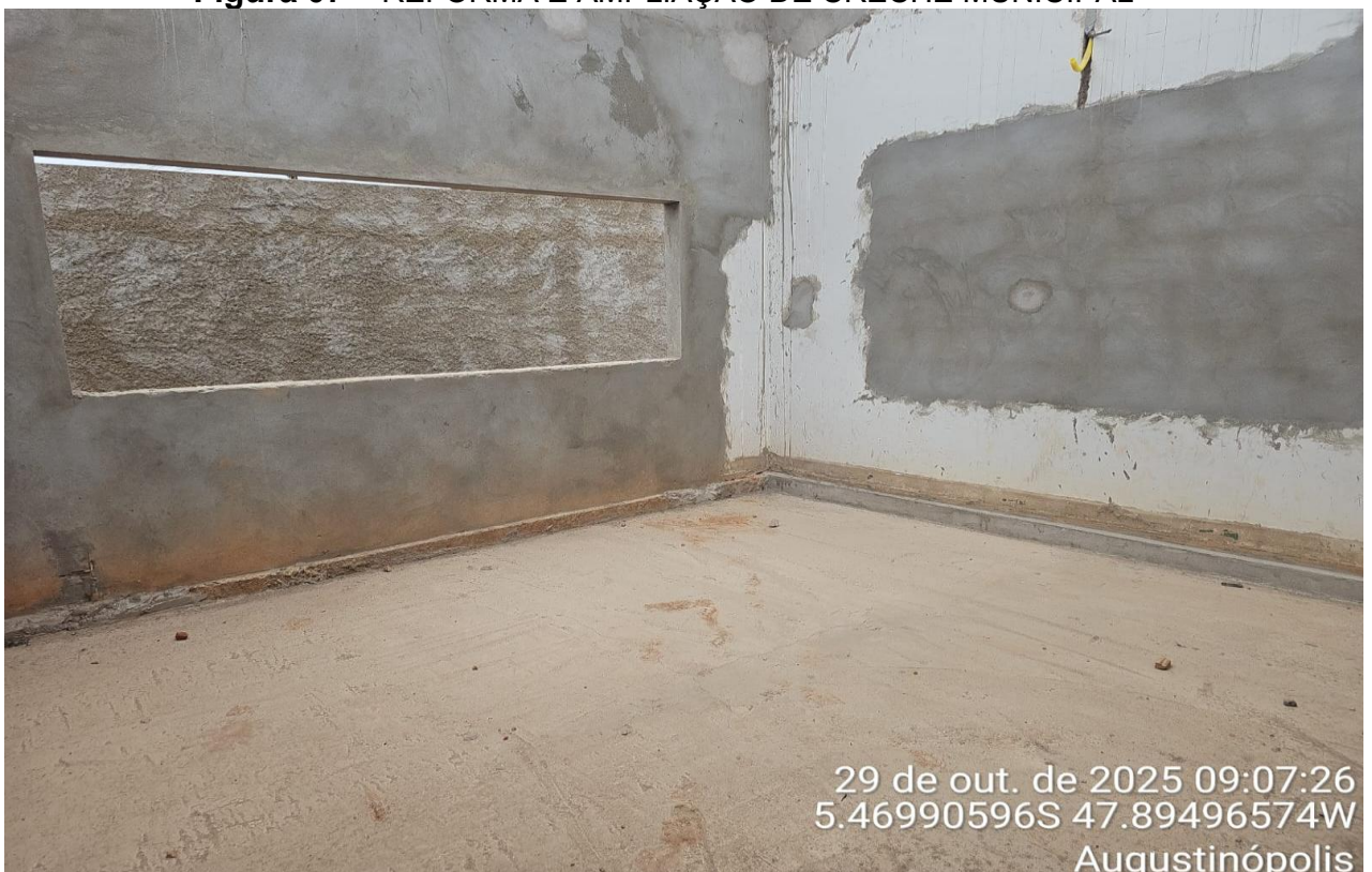
Figura 07 – REFORMA E AMPLIAÇÃO DE CRECHE MUNICIPAL
