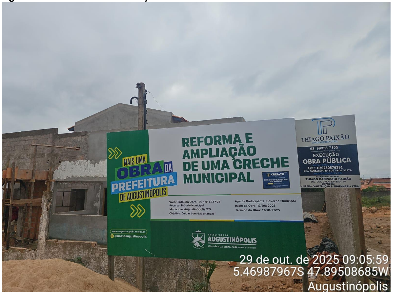
Figura 01 – REFORMA E AMPLIAÇÃO DE CRECHE MUNICIPAL
