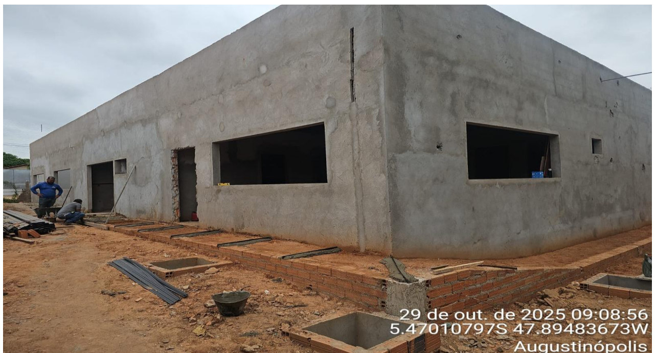
Figura 11 – REFORMA E AMPLIAÇÃO DE CRECHE MUNICIPAL
