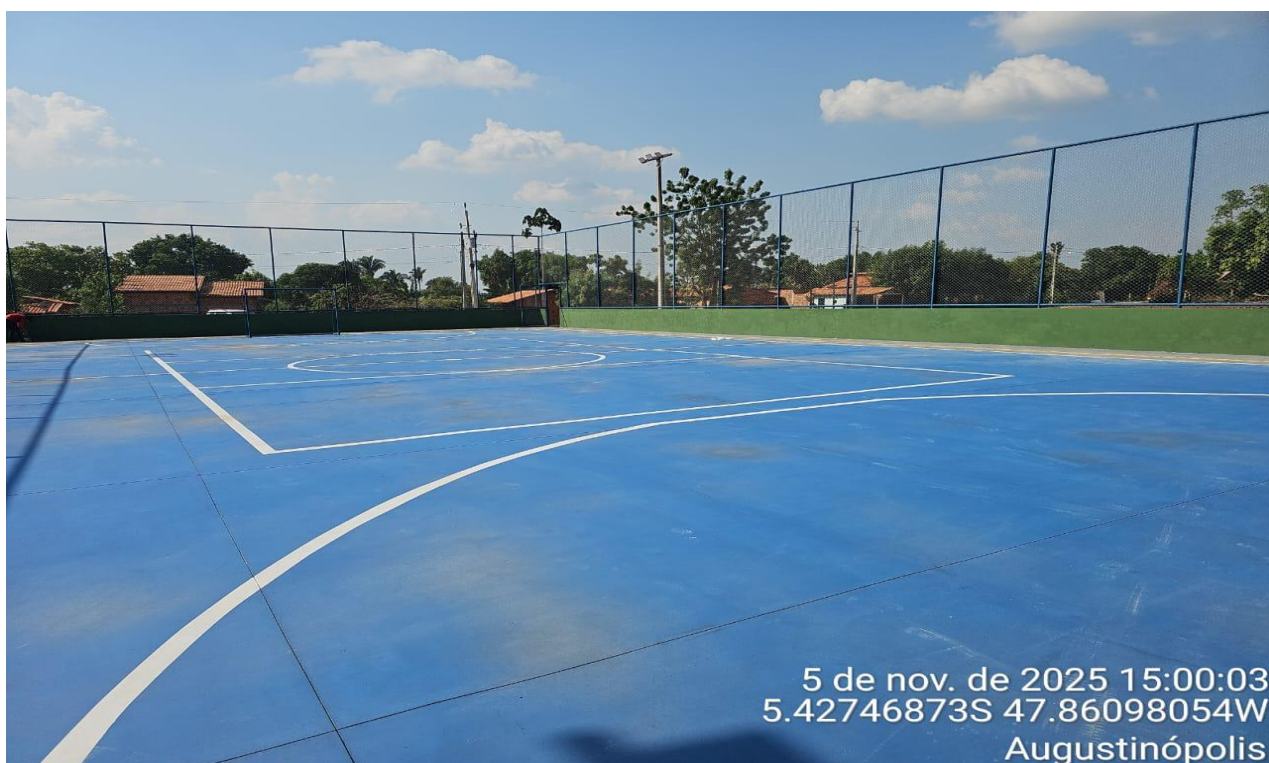
Figura 03 – CONSTRUÇÃO DA QUADRA POLIESPORTIVA
