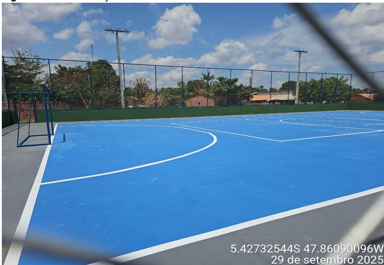
Figura 01 – CONSTRUÇÃO DA QUADRA POLIESPORTIVA
