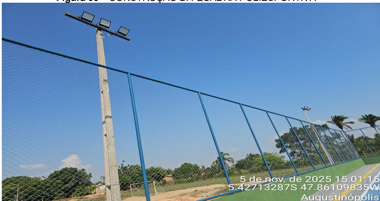
Figura 06 – CONSTRUÇÃO DA QUADRA POLIESPORTIVA
