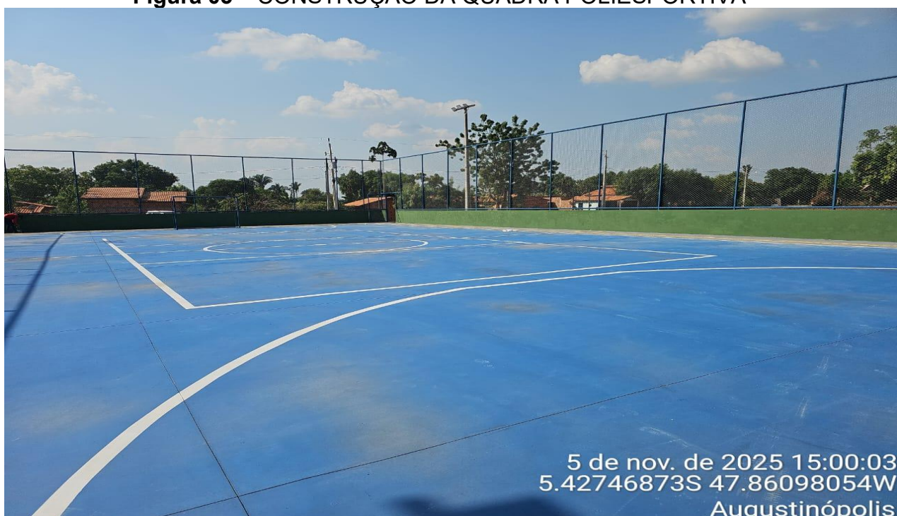
Figura 05 – CONSTRUÇÃO DA QUADRA POLIESPORTIVA
