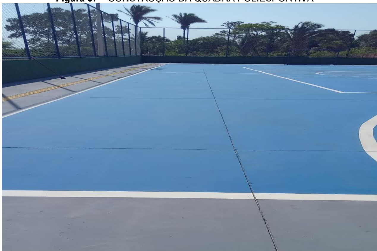
Figura 07 – CONSTRUÇÃO DA QUADRA POLIESPORTIVA
