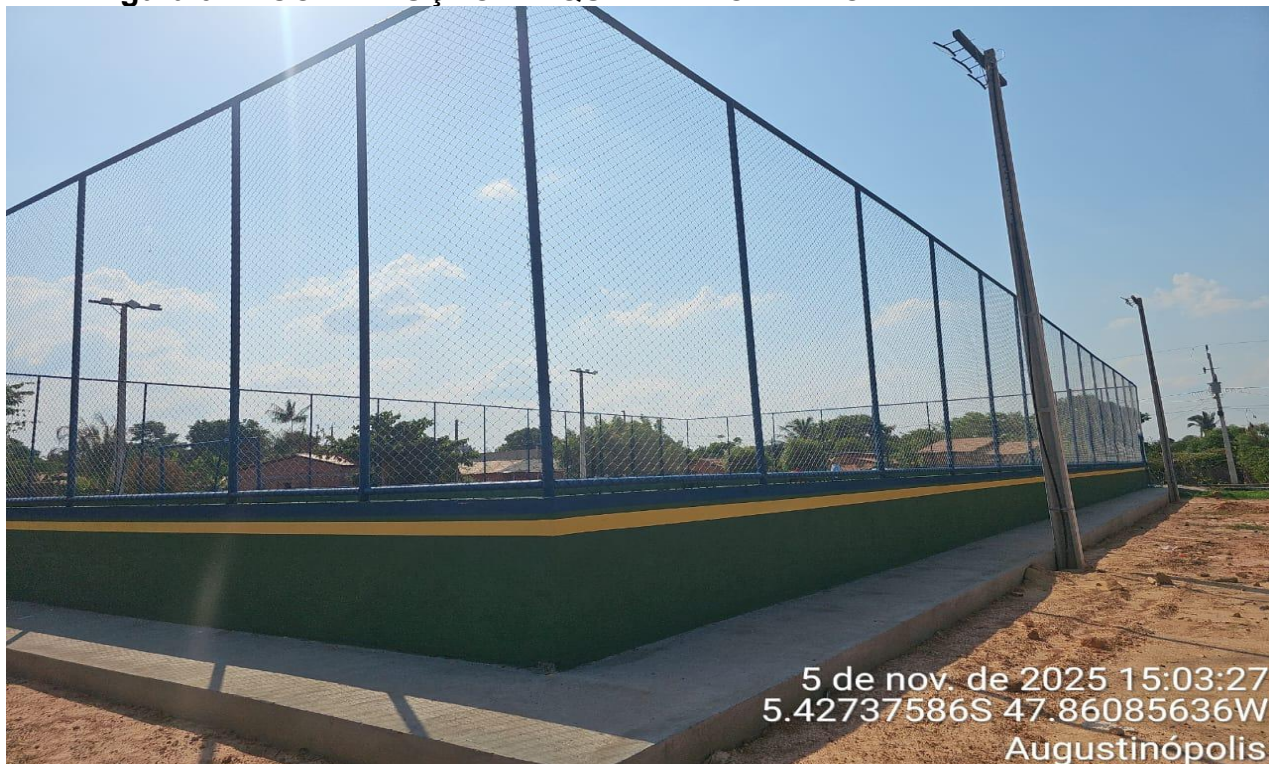
Figura 02 – CONSTRUÇÃO DA QUADRA POLIESPORTIVA
