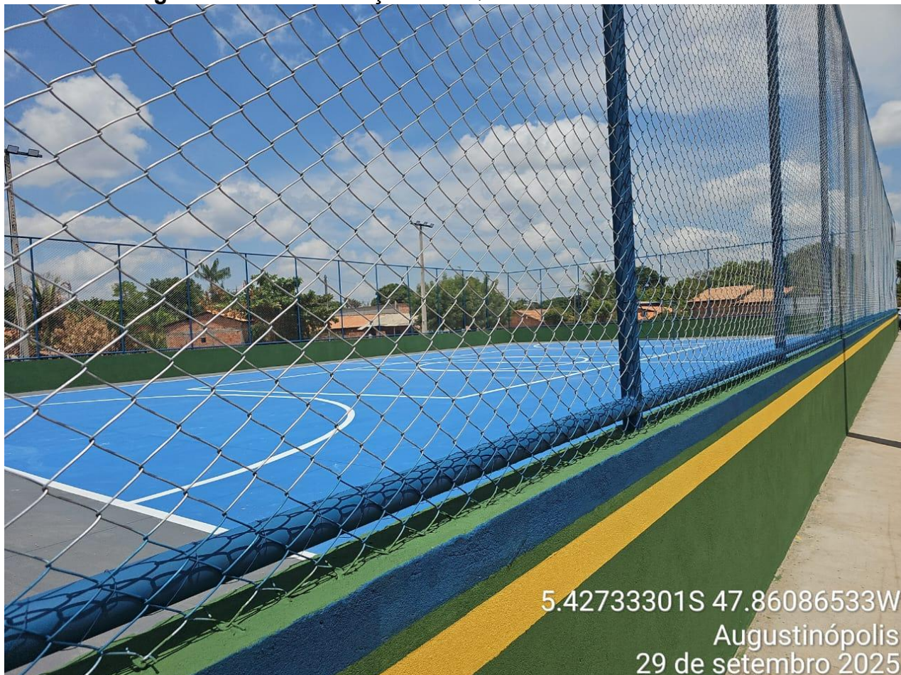
Figura 08 – CONSTRUÇÃO DA QUADRA POLIESPORTIVA
