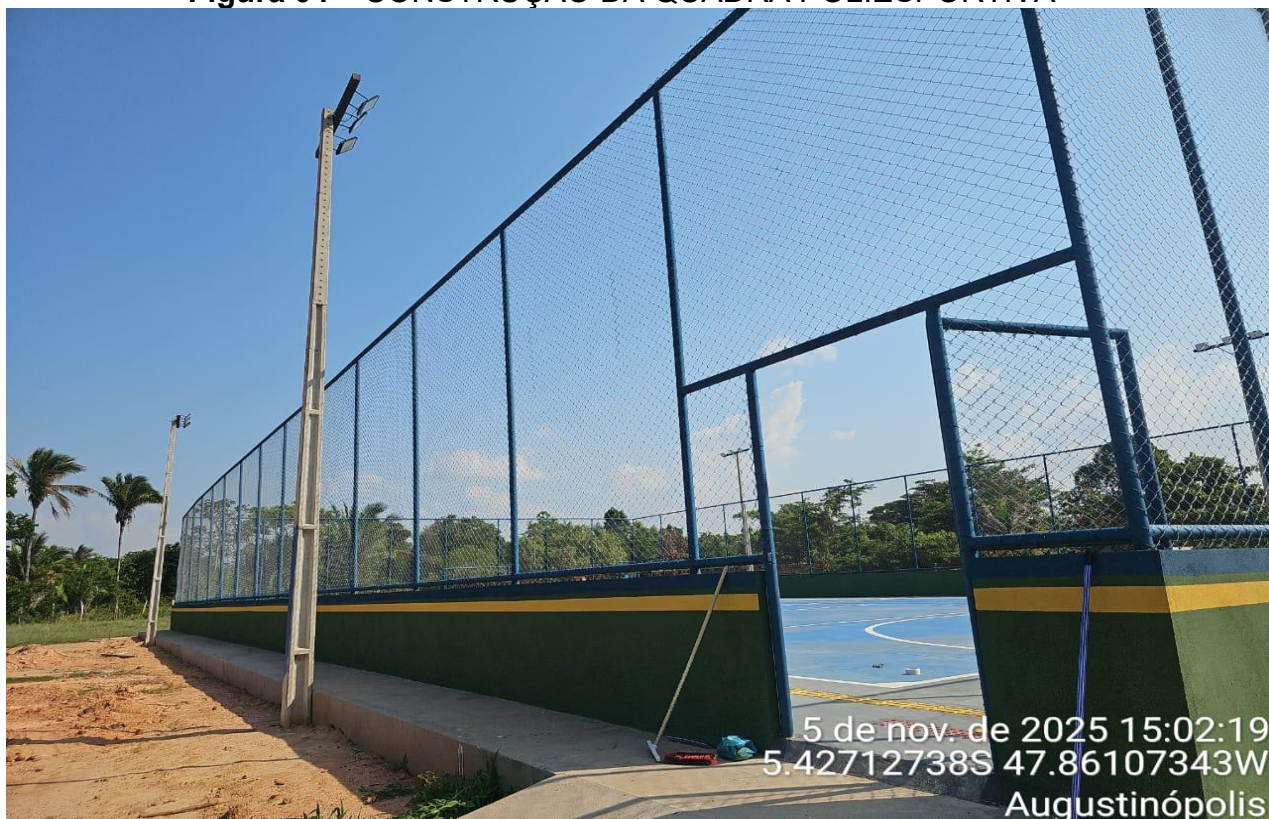
Figura 04 – CONSTRUÇÃO DA QUADRA POLIESPORTIVA
