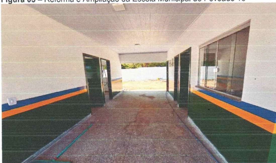
ÁREA INTERNA COM ACABAMENTOS FINALIZADOS
