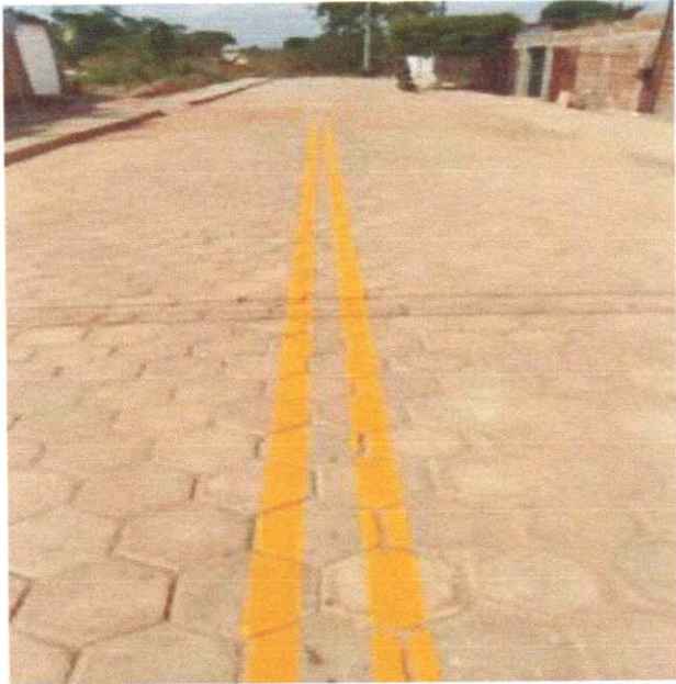
Meio fio, Sarjeta, Calçadas, Sinalização e Pavimentação em Bloquetes (Trecho I,II e III)
