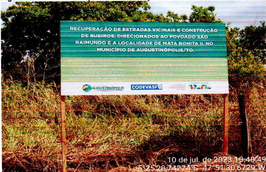
PLACA DE OBRA – TRECHO MATA BONITA II
