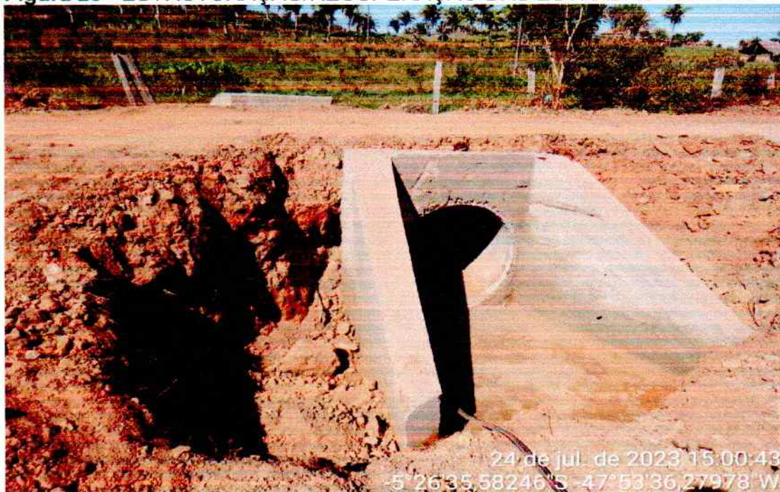
Figura 23 - ESTRUTURAÇÃO/RECUPERAÇÃO DAS ESTRADAS VICINAIS
