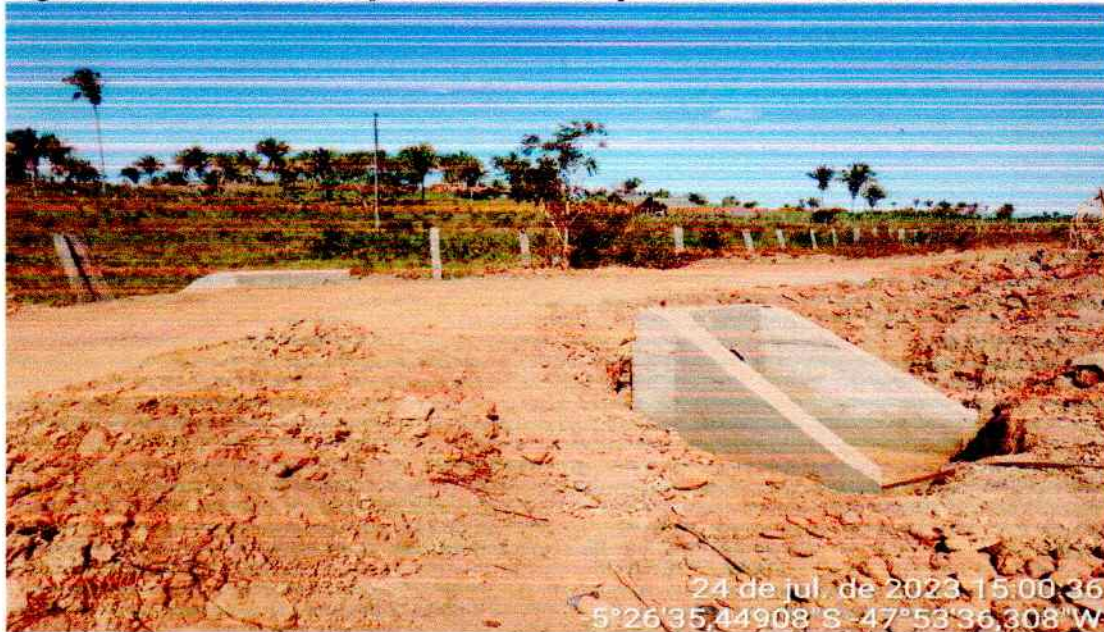
Figura 24 - ESTRUTURAÇÃO/RECUPERAÇÃO DAS ESTRADAS VICINAIS
