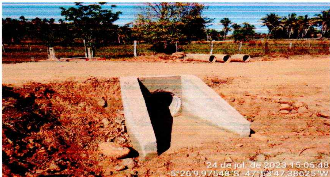
ESTRADA VICINAL DO TRECHO SÃO RAIMUNDO, BUEIROS EXECUTADO
