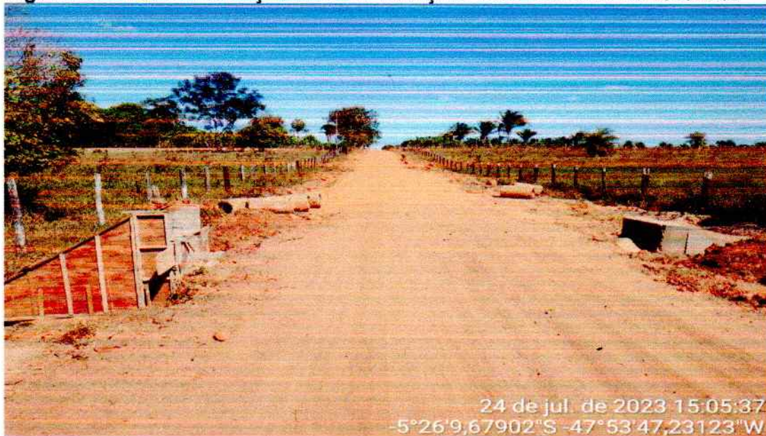
Figura 25 - ESTRUTURAÇÃO/RECUPERAÇÃO DAS ESTRADAS VICINAIS
