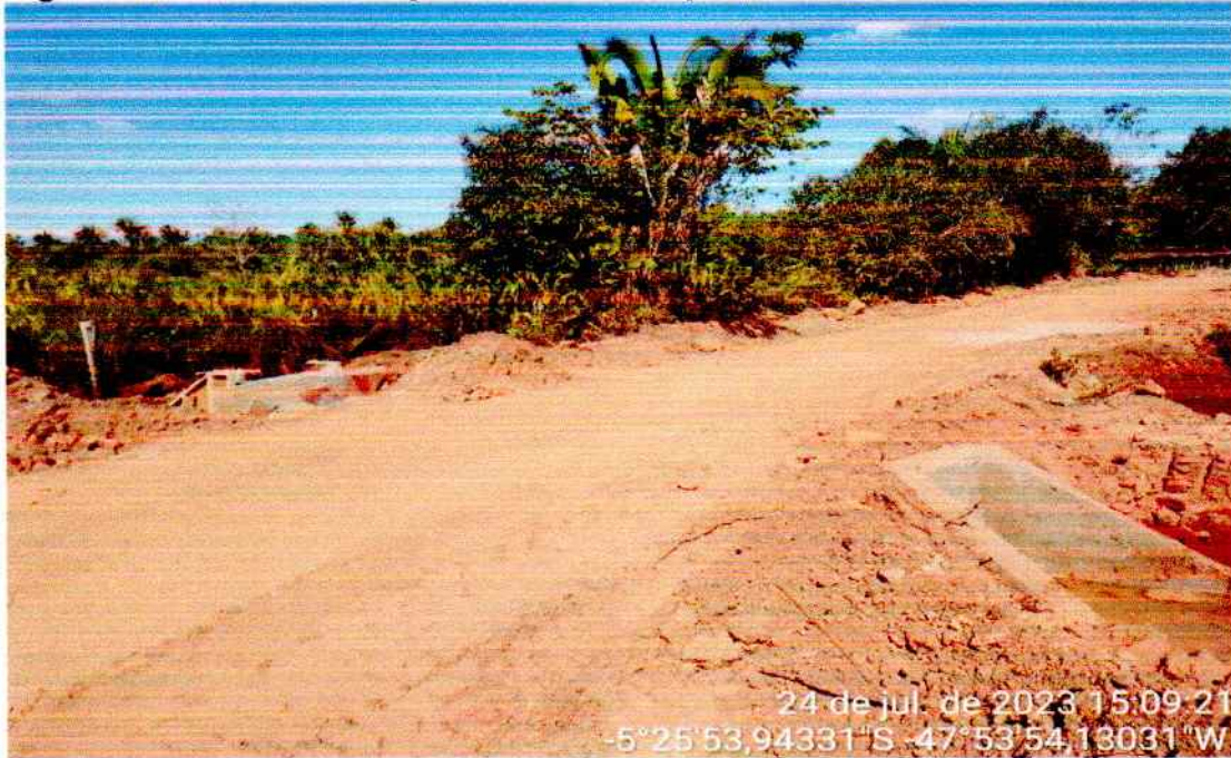
Figura 22 - ESTRUTURAÇÃO/RECUPERAÇÃO DAS ESTRADAS VICINAIS
