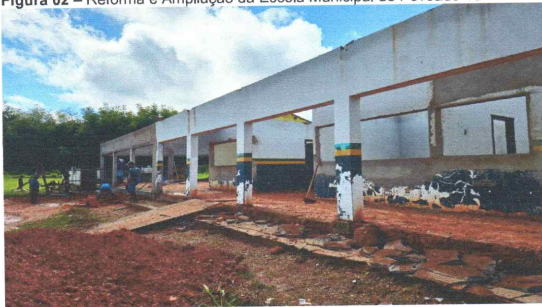
Remoção de portas e janelas, piso
