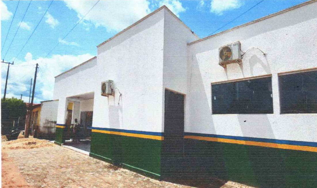
Figura 15 – REFORMA DO PREDIO CENTRO DE ATENÇÃO PSICOSSOCIAL
