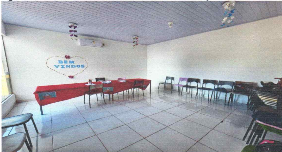
Figura 07 – REFORMA DO PREDIO CENTRO DE ATENÇÃO PSICOSSOCIAL
