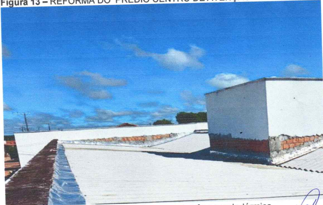
Cobertura com telha fibrocimento 6 mm, com rufo e manta térmica
