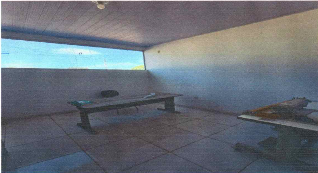
Figura 06 – REFORMA DO PREDIO CENTRO DE ATENÇÃO PSICOSSOCIAL
