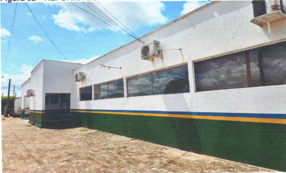
Figura 02 – REFORMA DO PREDIO CENTRO DE ATENÇÃO PSICOSSOCIAL
