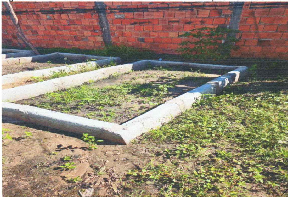
Figura 09 – REFORMA DO PREDIO CENTRO DE ATENÇÃO PSICOSSOCIAL
