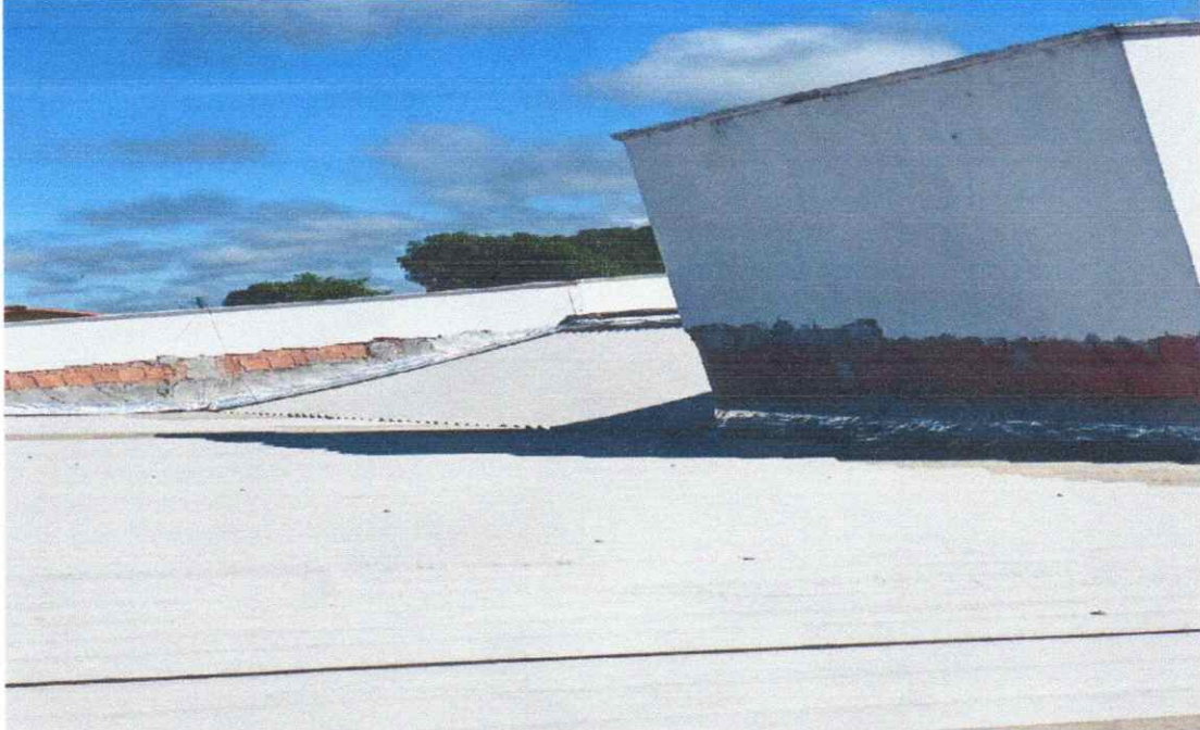
Figura 14 – REFORMA DO PREDIO CENTRO DE ATENÇÃO PSICOSSOCIAL
