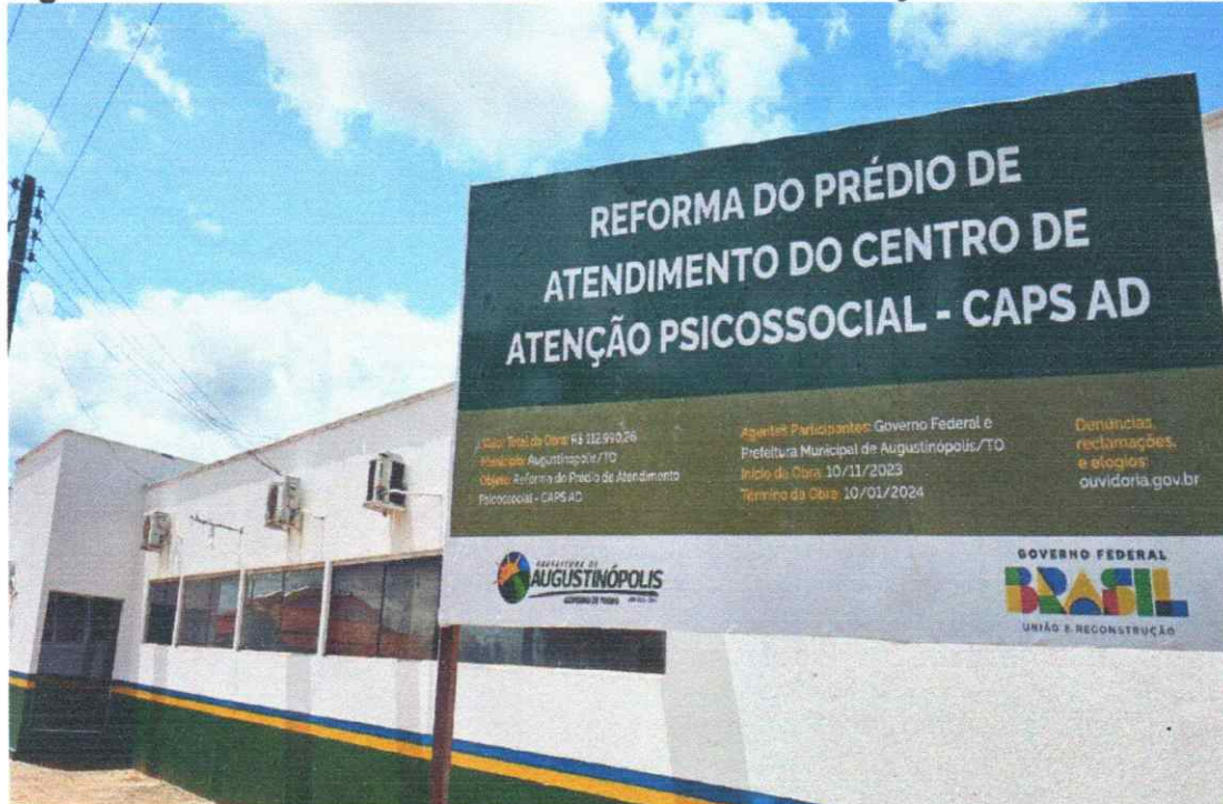
Figura 01 – REFORMA DO PREDIO CENTRO DE ATENÇÃO PSICOSSOCIAL
