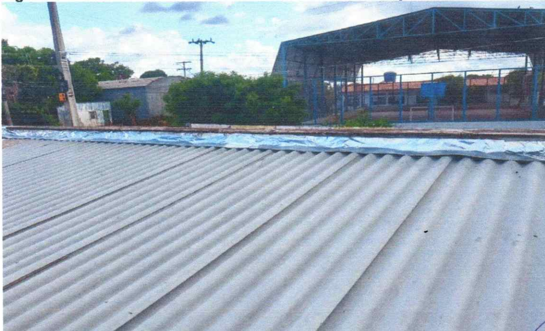
Cobertura com telha fibrocimento 6 mm, com rufo e manta térmica
