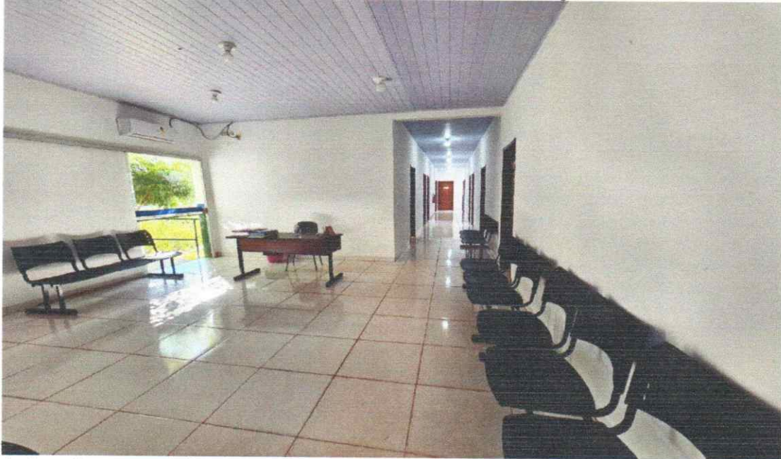
Aplicação manual de pintura com tinta latex acrilica em área interna.(recepção)
