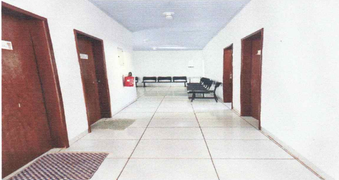
Figura 08 – REFORMA DO PREDIO CENTRO DE ATENÇÃO PSICOSSOCIAL
