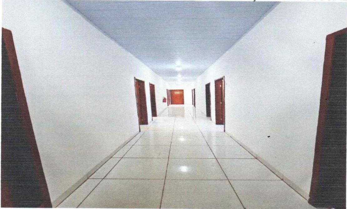
Aplicação manual de pintura com tinta latex acrilica em área interna.(corredor)
