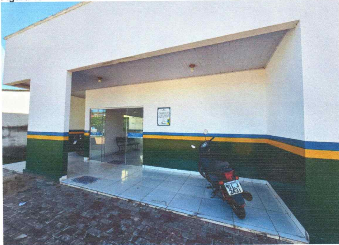
Aplicação manual de pintura com tinta latex acrilica em área externa.(fachada)
