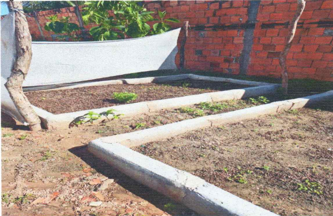
Assentamento de guia Meio fio pre moldado para canteiros
