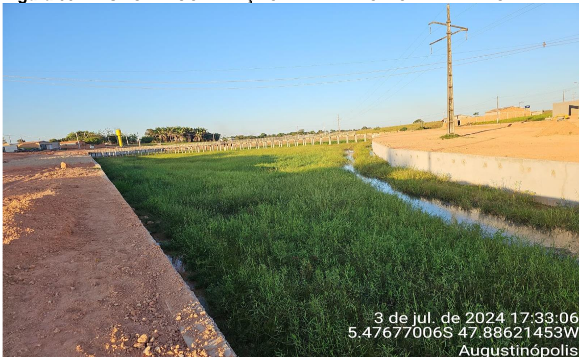
Figura 05 – MURO DE CONTENÇÃO DE ATERRO DO BALNEÁRIO
