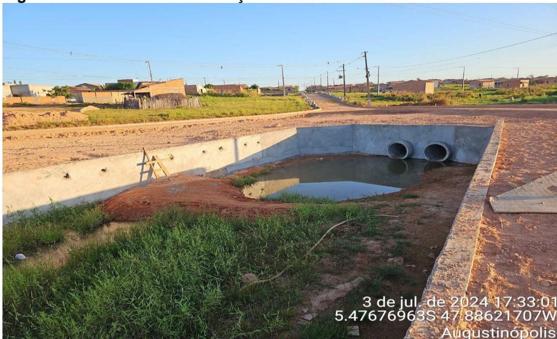
Figura 07 – MURO DE CONTENÇÃO DE ATERRO DO BALNEÁRIO
