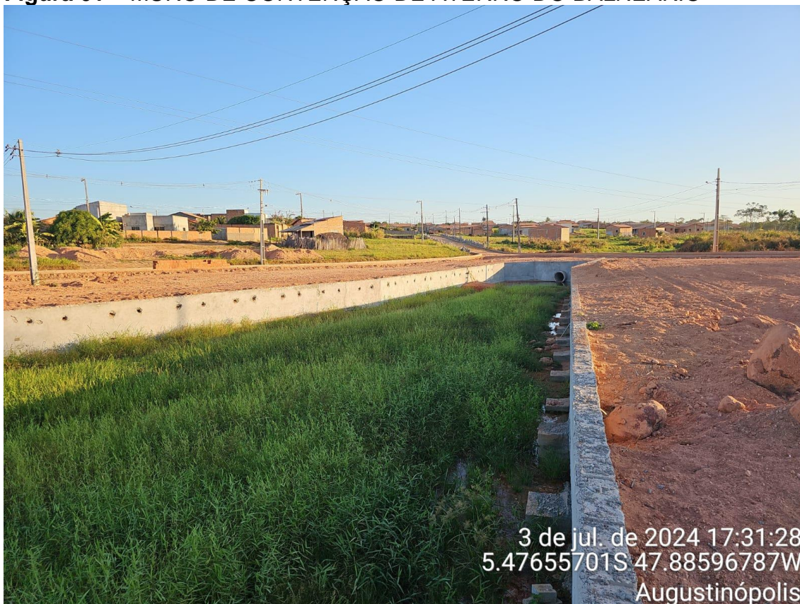
MURO DE CONTENÇÃO EM BLOCOS ESTRUTURAIS DE CONCRETO ARMADO
