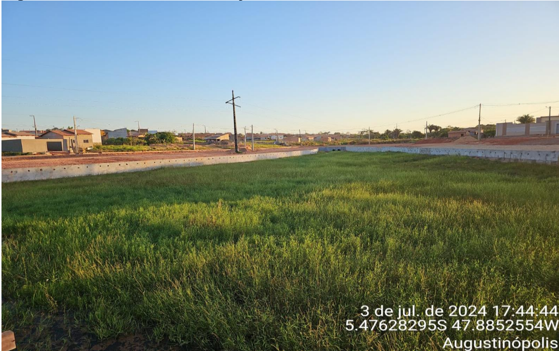
Figura 08 – MURO DE CONTENÇÃO DE ATERRO DO BALNEÁRIO
