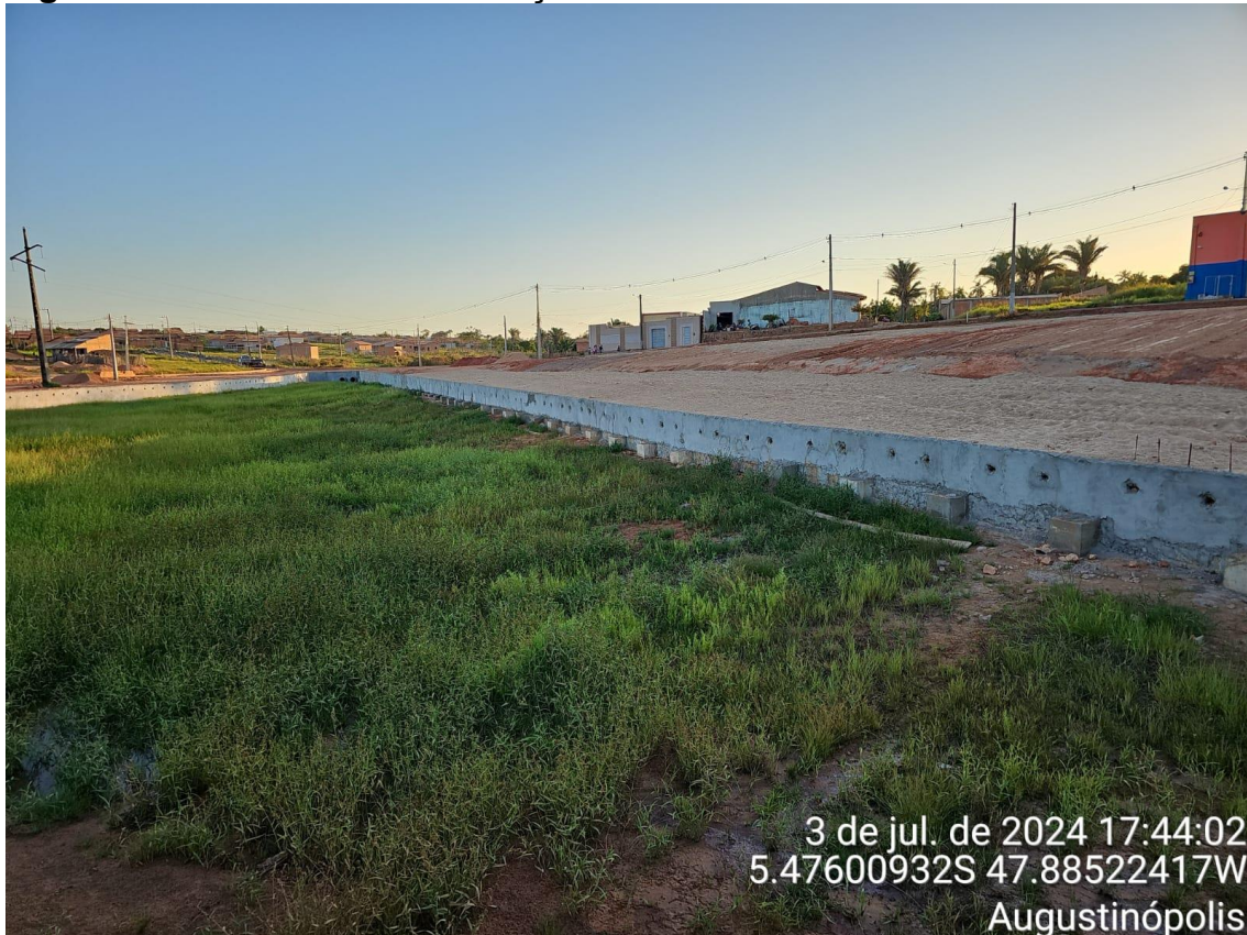
Figura 10 – MURO DE CONTENÇÃO DE ATERRO DO BALNEÁRIO
