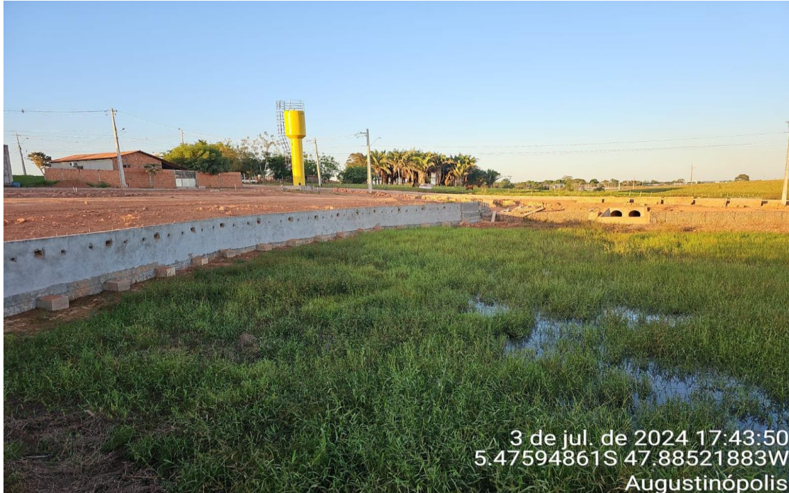
Figura 06 – MURO DE CONTENÇÃO DE ATERRO DO BALNEÁRIO
