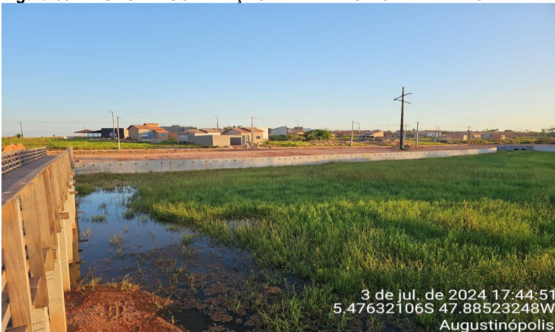
Figura 09 – MURO DE CONTENÇÃO DE ATERRO DO BALNEÁRIO
