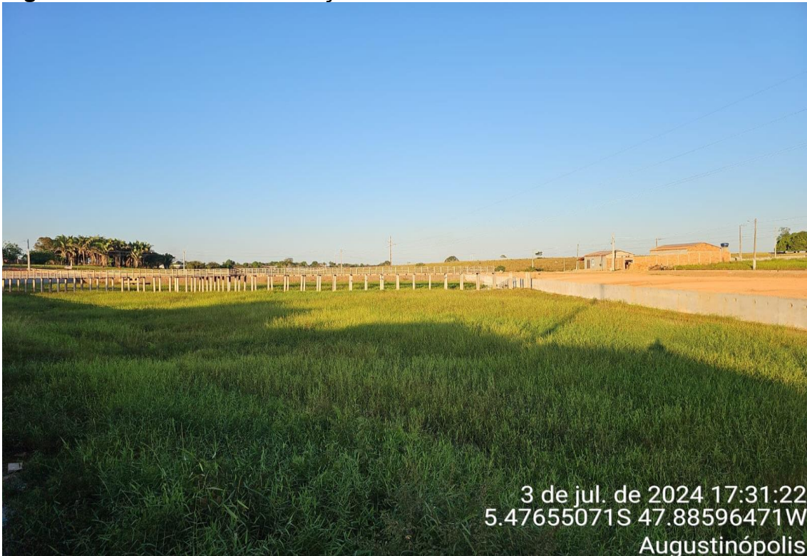
MURO DE CONTENÇÃO EM BLOCOS ESTRUTURAIS DE CONCRETO ARMADO
