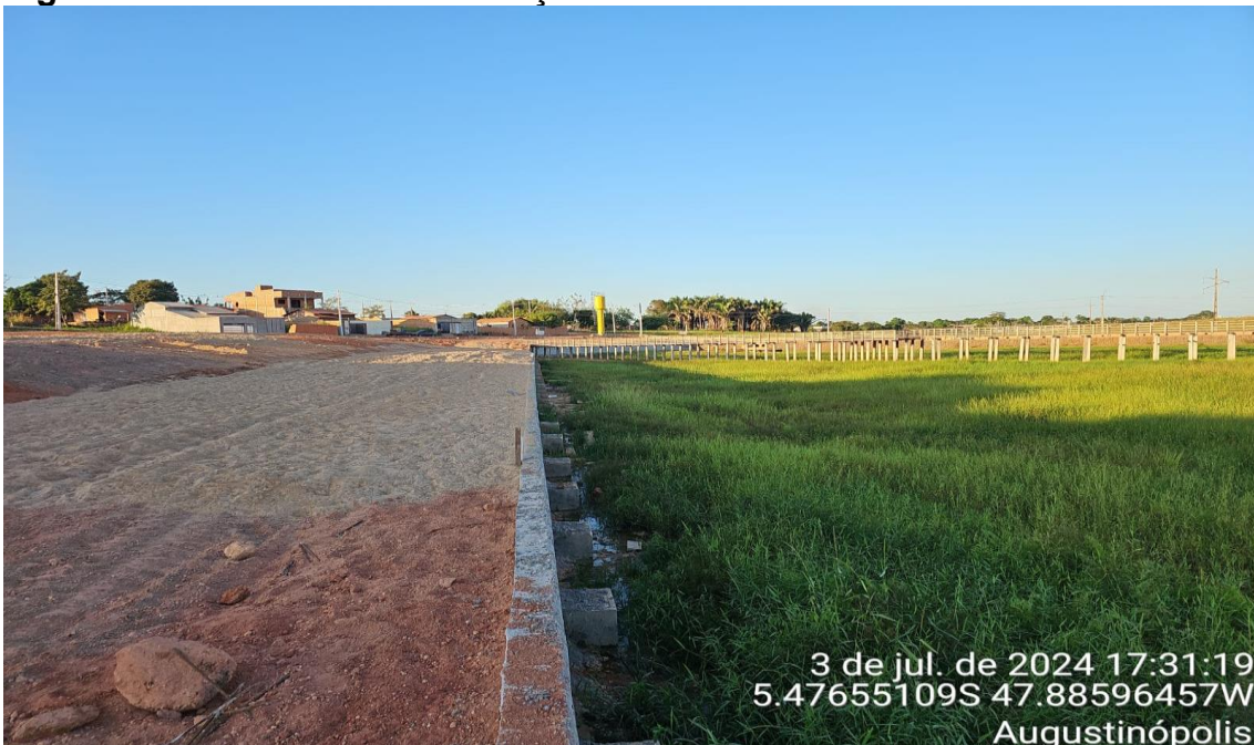
MURO DE CONTENÇÃO EM BLOCOS ESTRUTURAIS DE CONCRETO ARMADO
