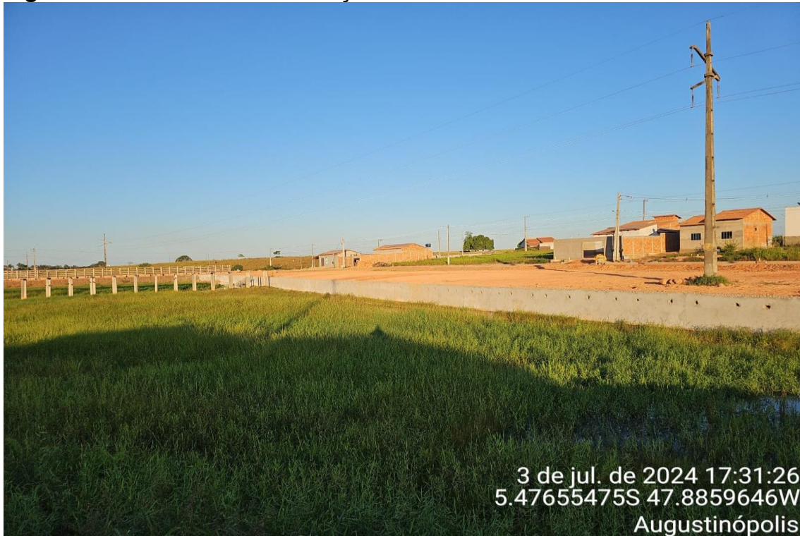
Figura 04 – MURO DE CONTENÇÃO DE ATERRO DO BALNEÁRIO
