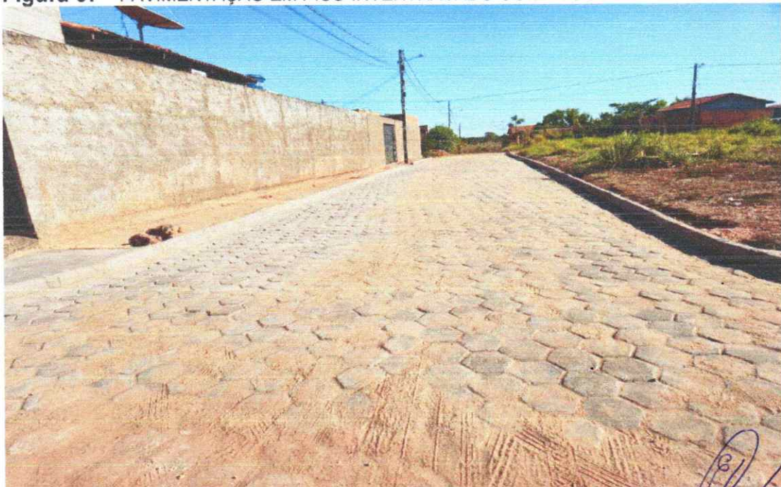
Figura 07 - PAVIMENTAÇÃO EM PISO INTERTRAVADO COM BLOCOS SEXTAVADOS
