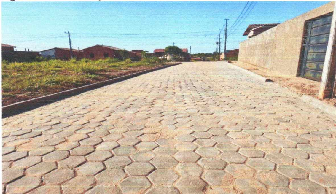
Figura 08 - PAVIMENTAÇÃO EM PISO INTERTRAVADO COM BLOCOS SEXTAVADOS
