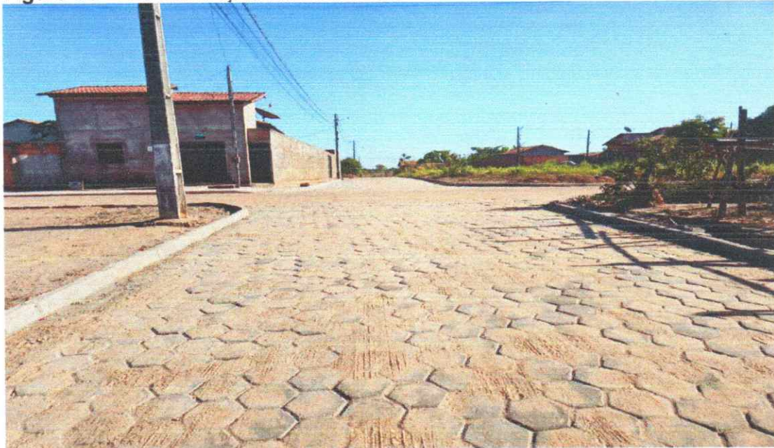
Figura 06 - PAVIMENTAÇÃO EM PISO INTERTRAVADO COM BLOCOS SEXTAVADOS
