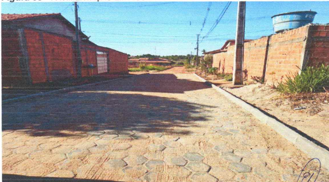
Figura 05 - PAVIMENTAÇÃO EM PISO INTERTRAVADO COM BLOCOS SEXTAVADOS
