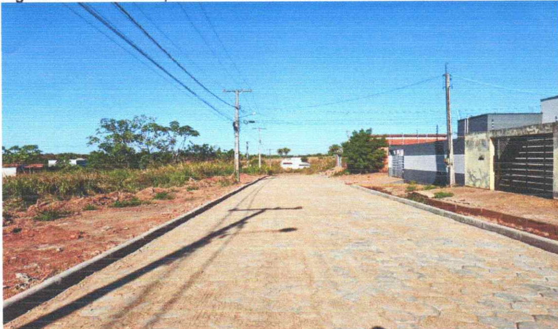
Figura 04 - PAVIMENTAÇÃO EM PISO INTERTRAVADO COM BLOCOS SEXTAVADOS
